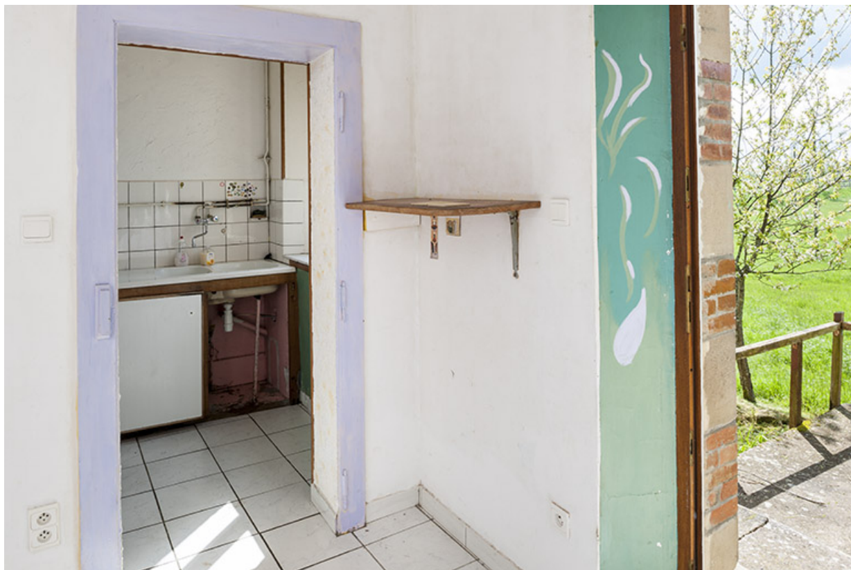
Arrière-cuisine, maison du barragiste. 70, Montureux-lès-Baulay
