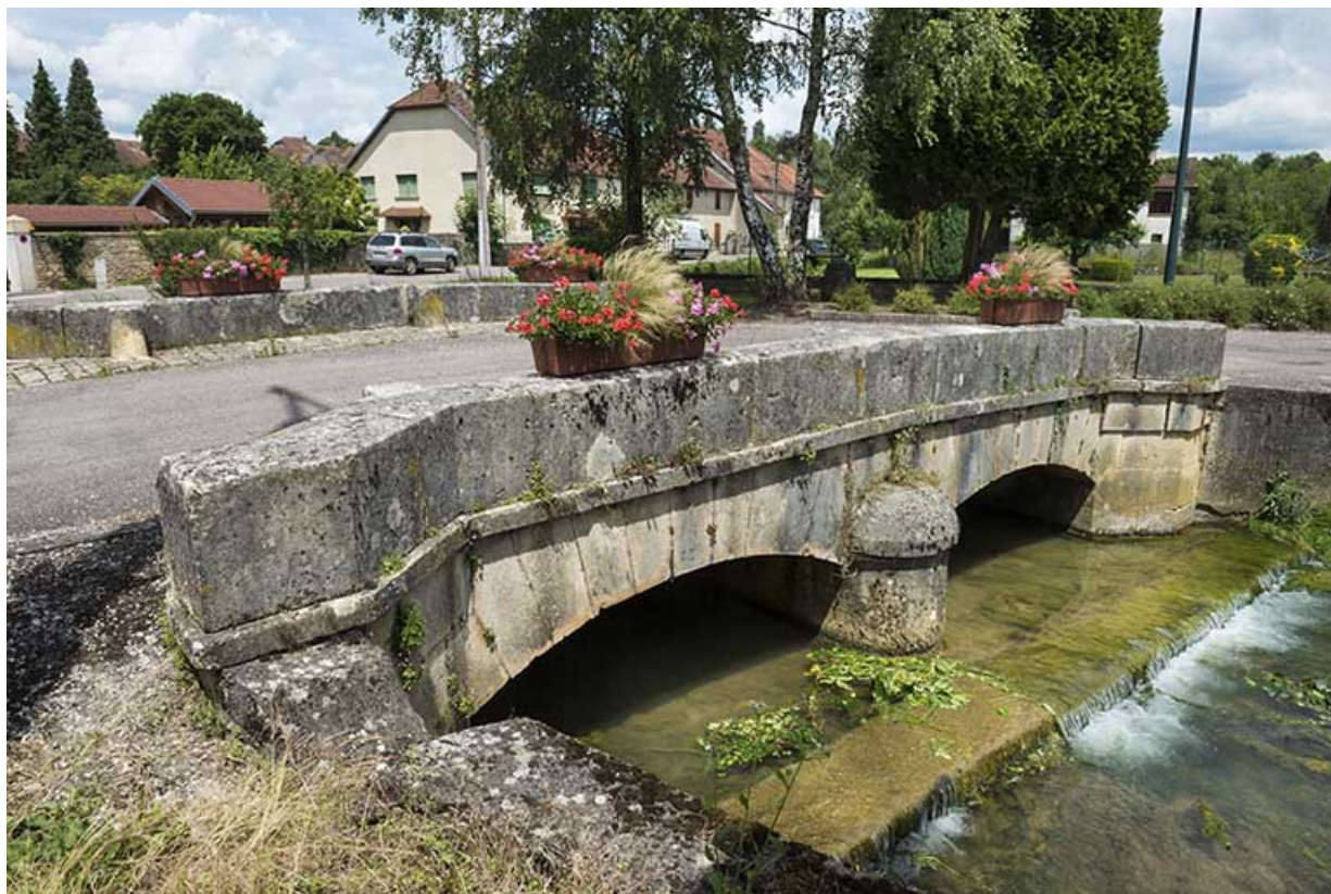
Face sud, vue depuis l'ouest.
