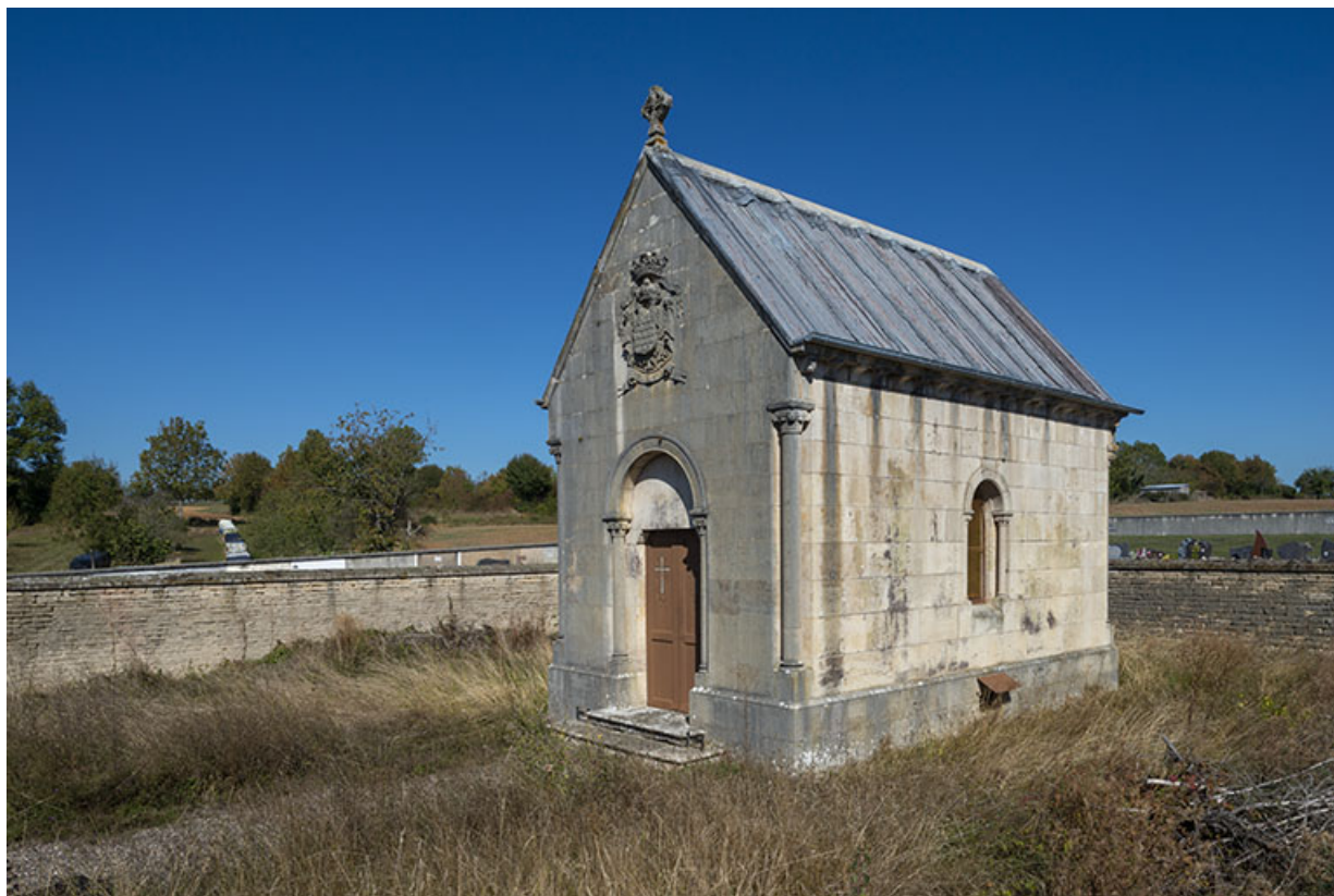
Chapelle funéraire de la famille Bauffremont, vue depuis le sud.
