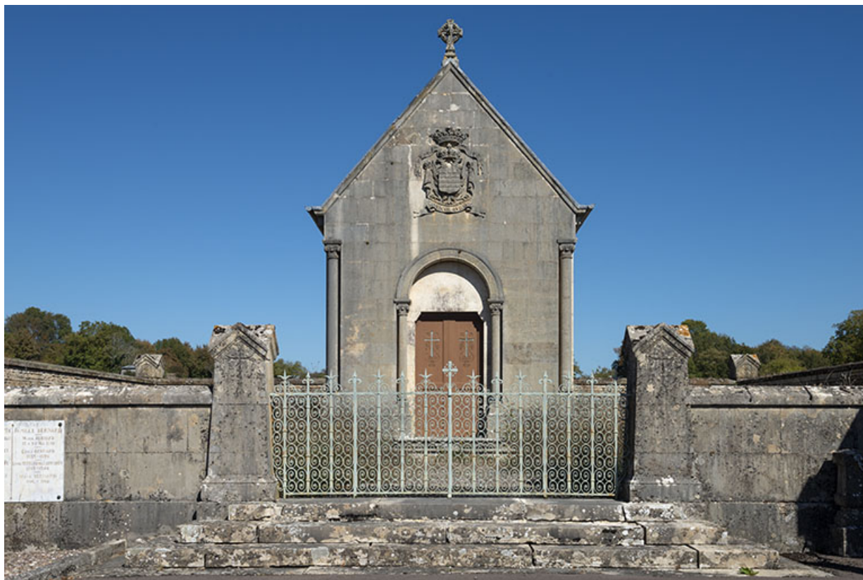
Enclos funéraire de la famille Bauffremont, vue depuis le sud-ouest.
