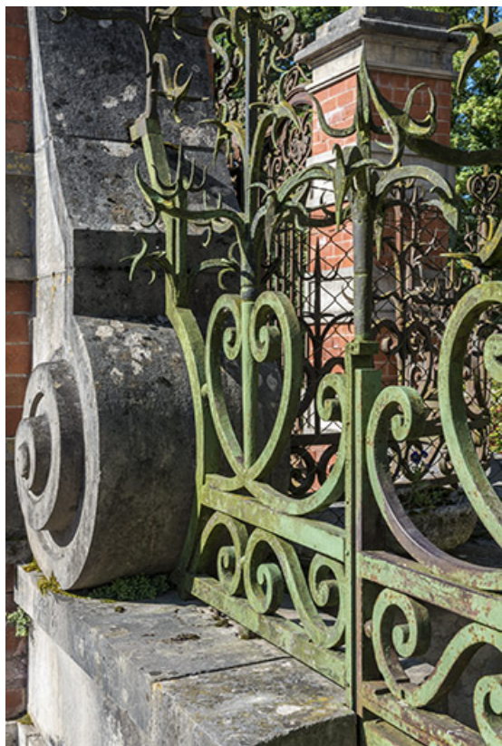
Clôture (grille) sur la rue Armand Paulmard.
