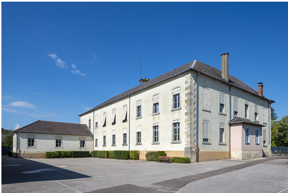
Élévation depuis le sud, du côté de la cour de récréation.
