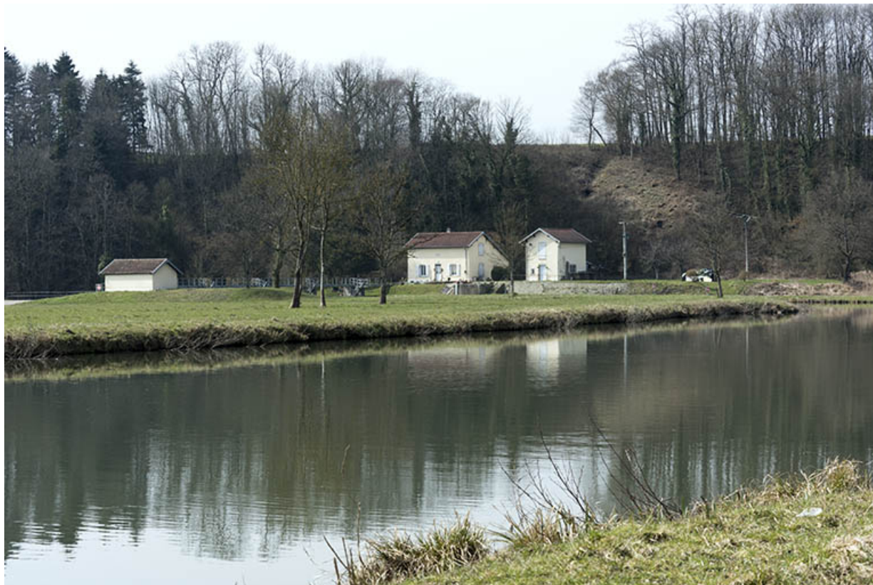
La saône et le site du barrage mobile. 70, Ormoy
