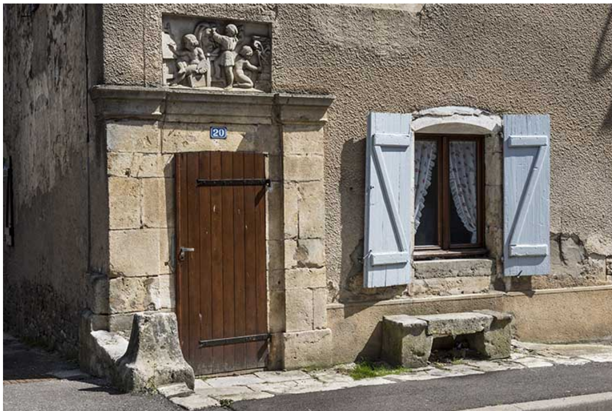
Porte d'entrée et fenêtre au rez-de-chaussée, façade antérieure.
