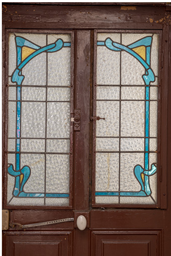
Porte de la cage d'escalier donnant sur le jardin, vitrail de style Art Nouveau. 70, Scey-sur-Saône-et-Saint-Albin, 1 chemin des Vignes
