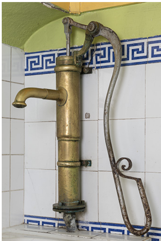
Rez-de-chaussée, cuisine, pompe à main.
