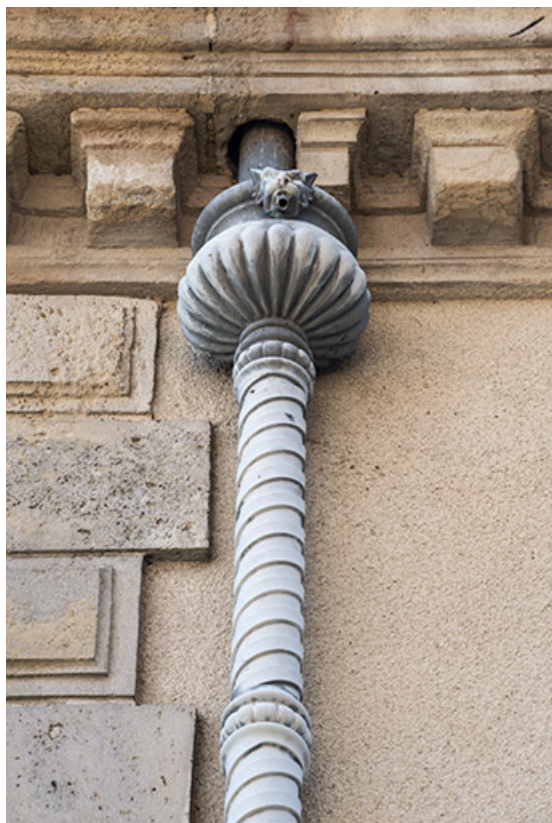
Descente d'eau en hélice avec cuvette godronnée.
