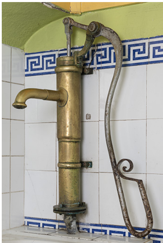
Rez-de-chaussée, cuisine, pompe à main.
