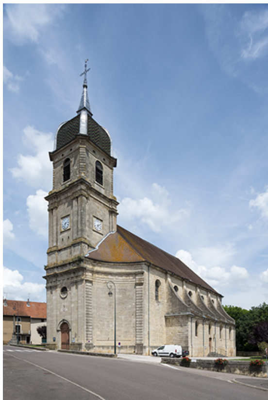
Vue d'ensemble depuis la rue de l'Église.
