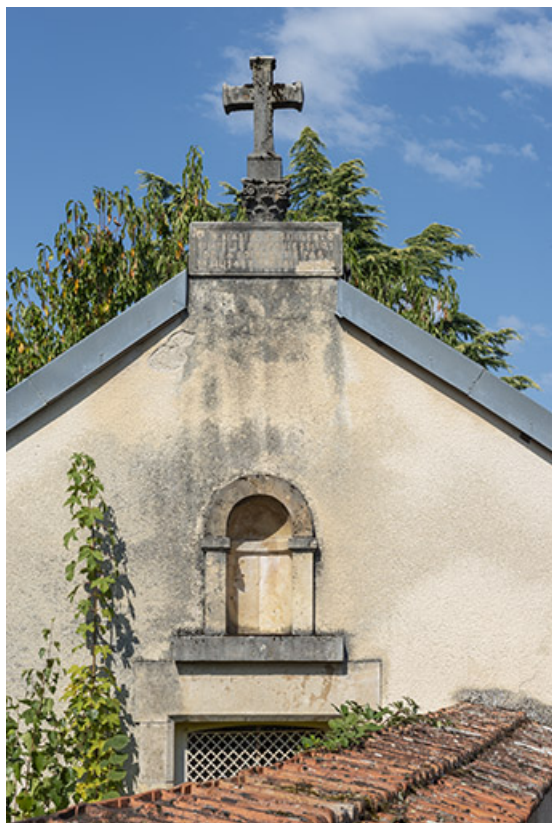
Pignon avec niche surmontée d'une inscription, d'un chapiteau et d'une croix. 70, Scey-sur-Saône-et-Saint-Albin rue des Vignes
