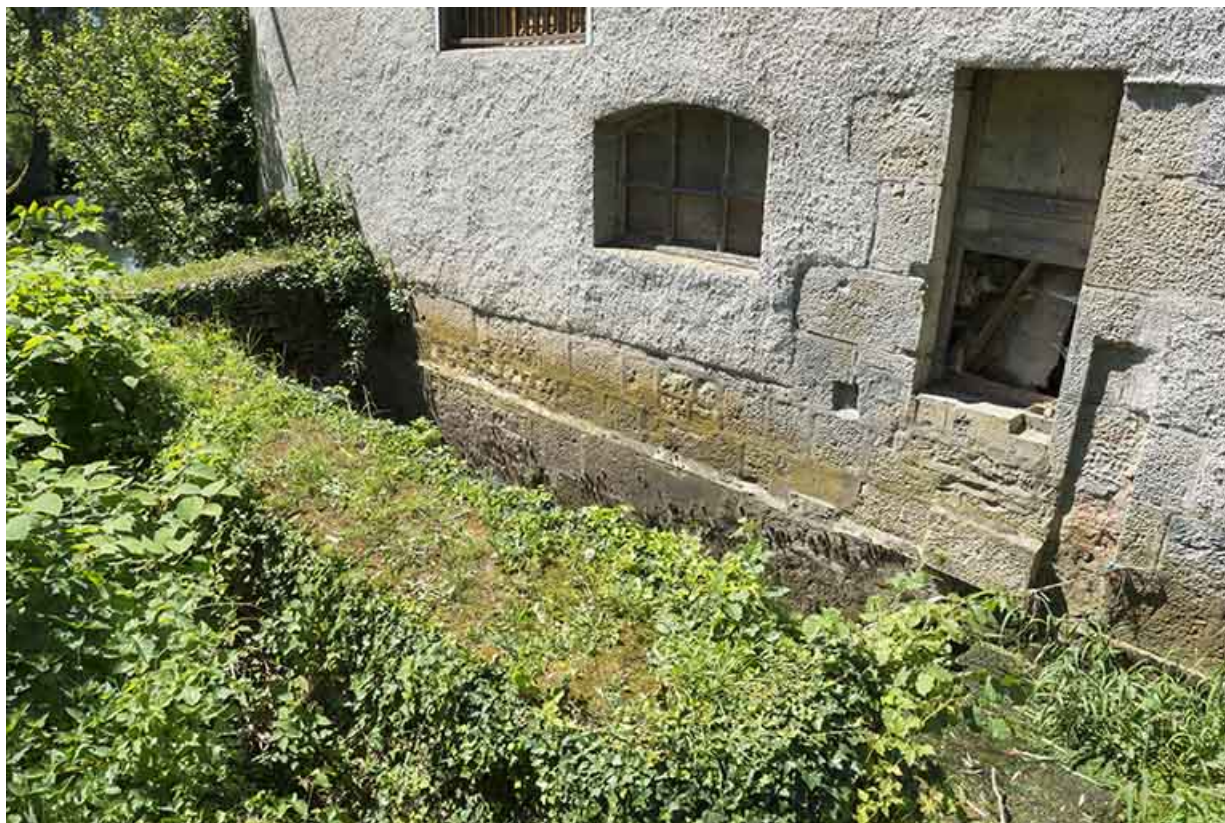
Élévation sur le ruisseau, détail.
