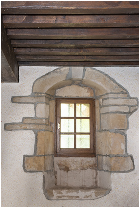
Détail d'une fenêtre, ancienne cure.
