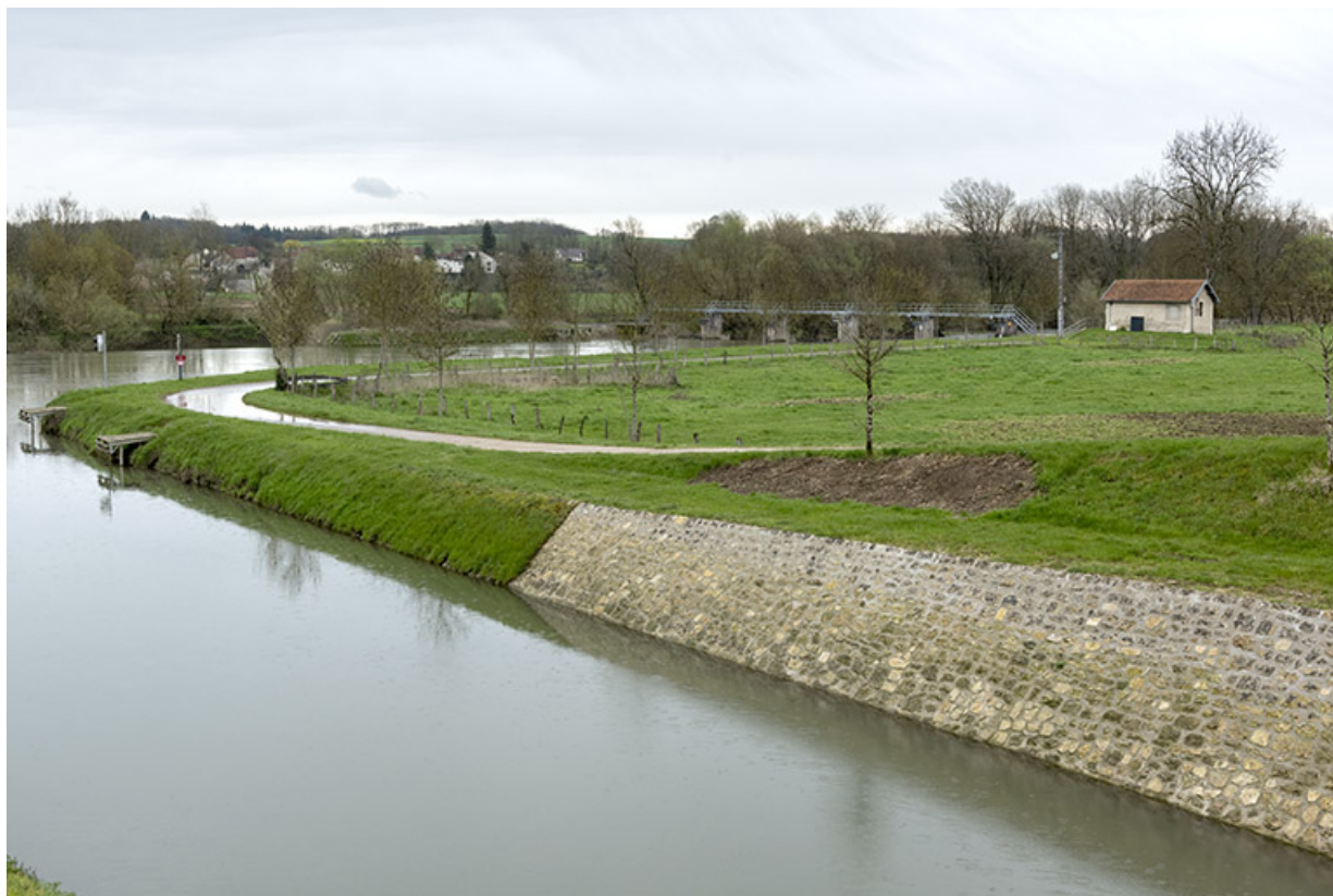
Vue depuis l'entrée amont du canal.
