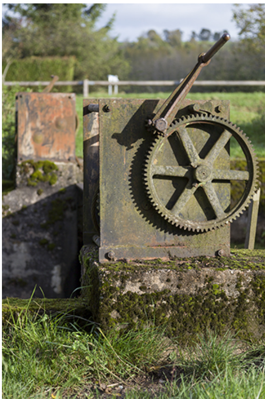
Mécanisme manuel pour ouvrir les portes de l'écluse. 70, Rupt-sur-Saône
