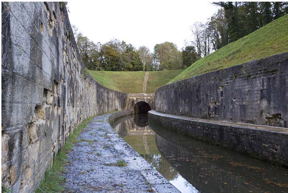
L'entrée du tunnel en aval, vue depuis la banquette de halage.
