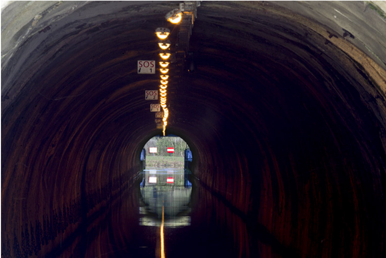
Le tunnel, vue intérieure.
