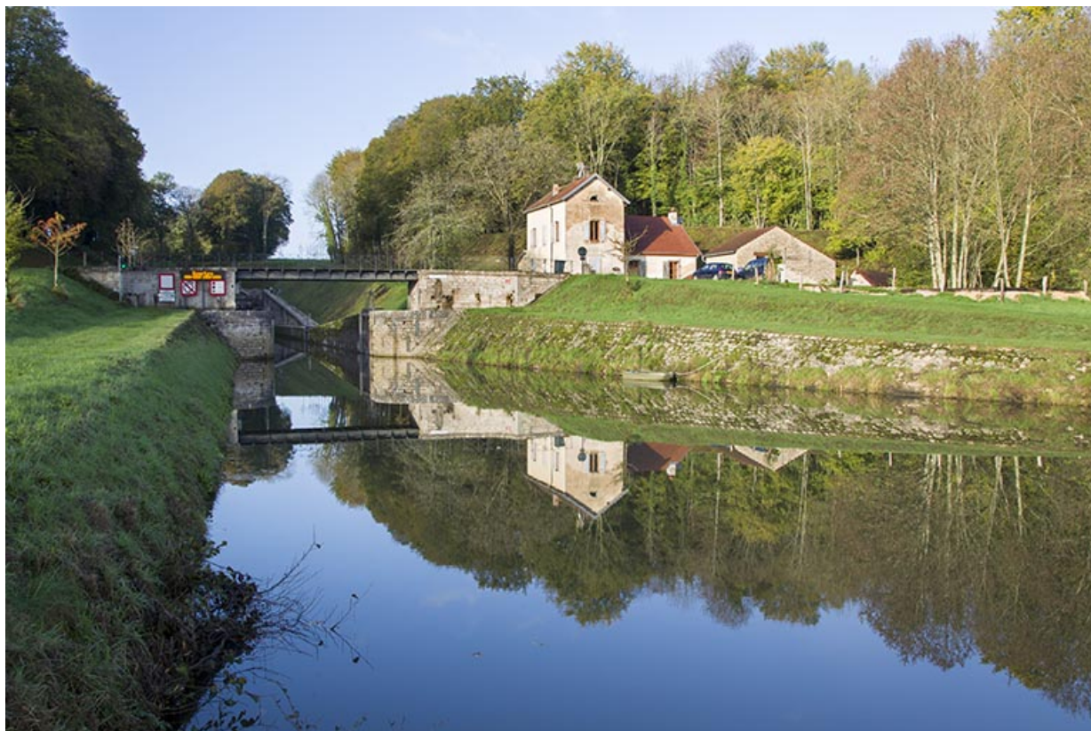
Entrée du canal depuis l'amont. 70, Scey-sur-Saône-et-Saint-Albin
