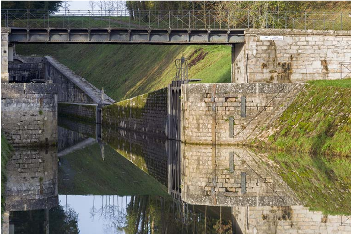
Entrée du canal amont et l'écluse de garde. 70, Sceaux-sur-Saône-et-Saint-Albin
