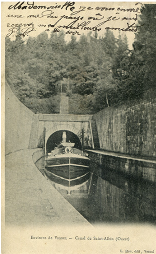
Le canal en aval du tunnel, carte postale.
