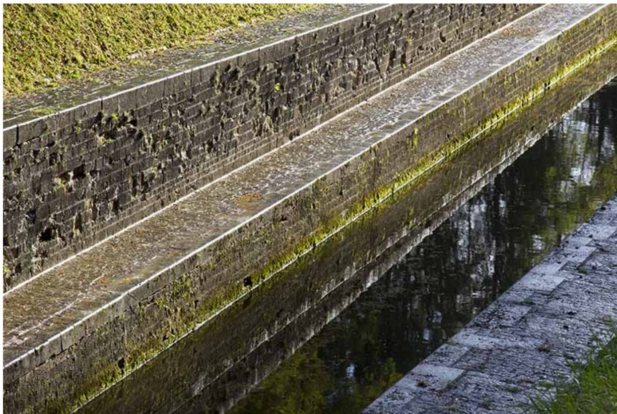
Vue sur la maçonnerie du canal.
