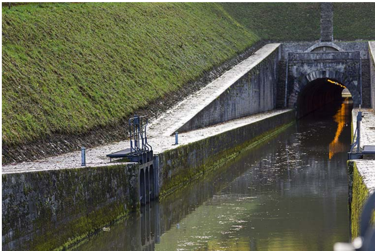
Le tunnel, vue amont.
