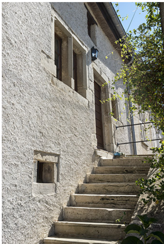
L'escalier extérieur permettant d'accéder à l'étage carré.
