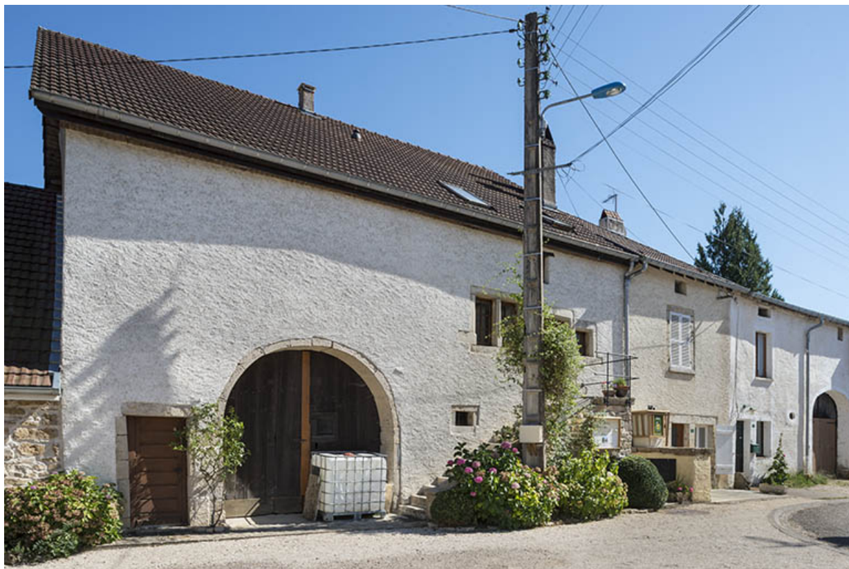
La porte charretière, façade antérieure.
