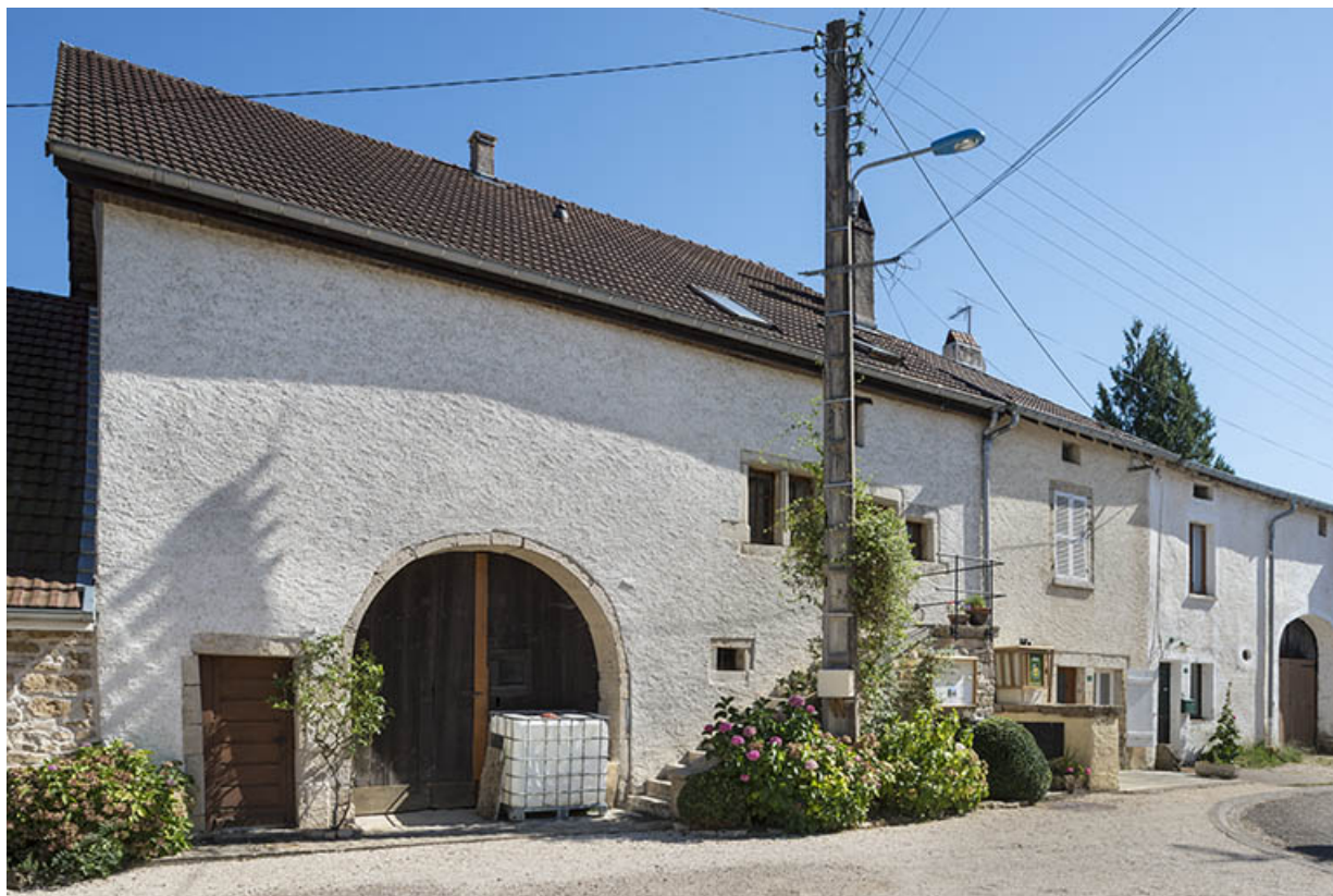
La porte charretière, façade antérieure.
