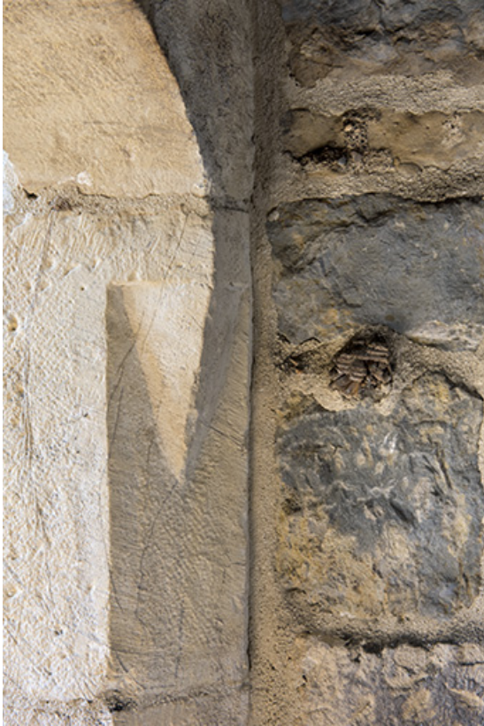
Détail sculpté des piédroits de la cheminée.
