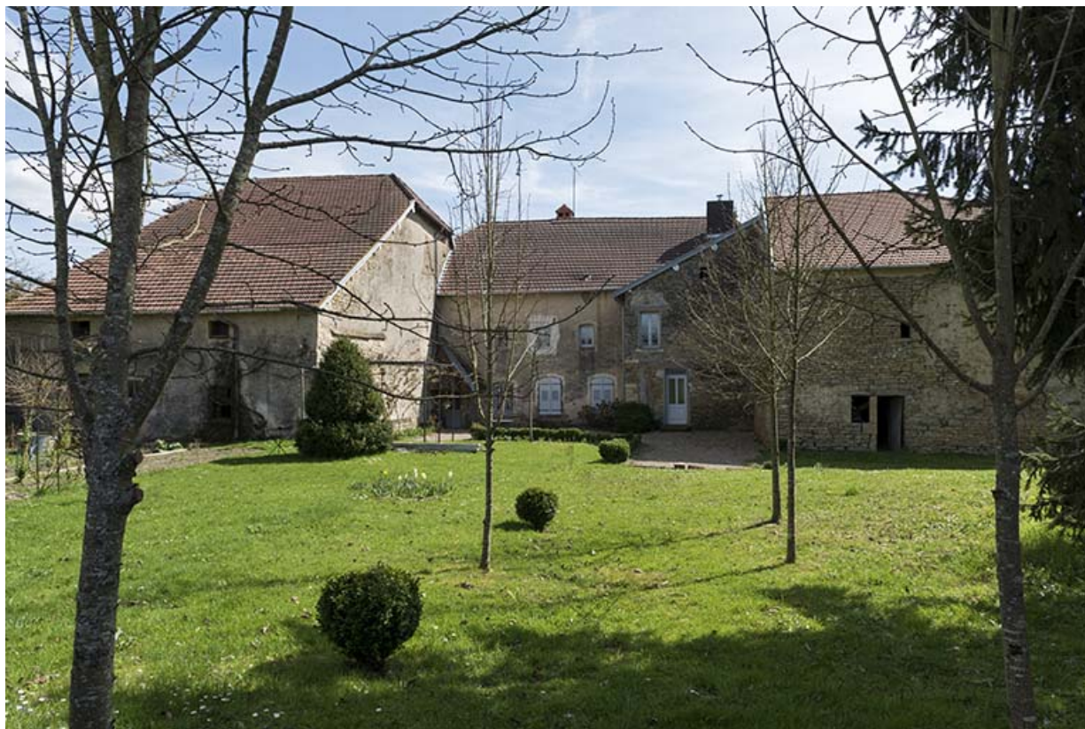
Vue de la façade postérieure depuis la rue de la Fontaine au nord-ouest. 70, Betaucourt place du Petit-Magny
