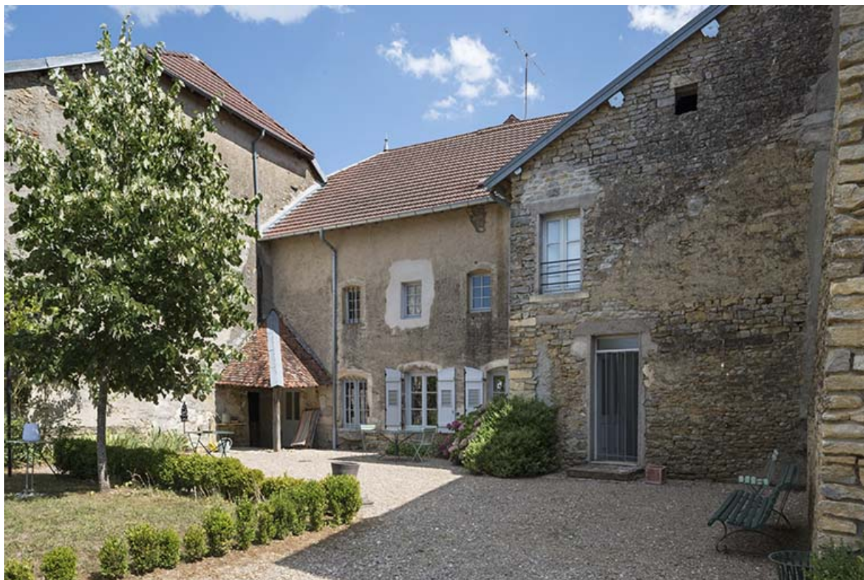
Vue rapprochée de trois-quart nord-ouest de la façade postérieure.
