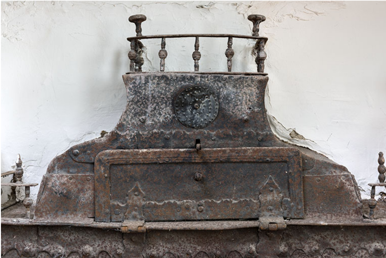
Détail de la partie chauffe-plat du poêle-récupérateur de chaleur.
