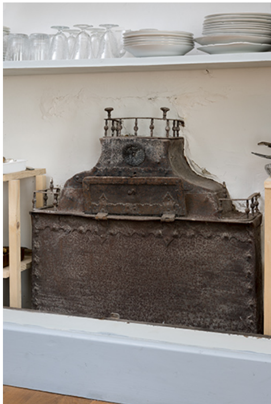
poêle-récupérateur de chaleur dans le placard chauffant de la salle à manger. Vue rapprochée. 70, Betaucourt place du Petit-Magny
