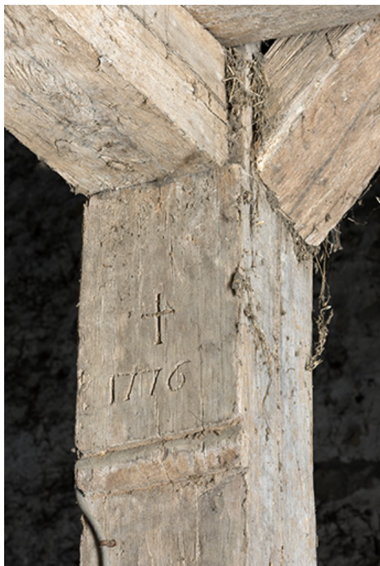
Détail de date (1776) et de croix sculptée sur un poteau de la charpente de la grange. 70, Betaucourt place du Petit-Magny
