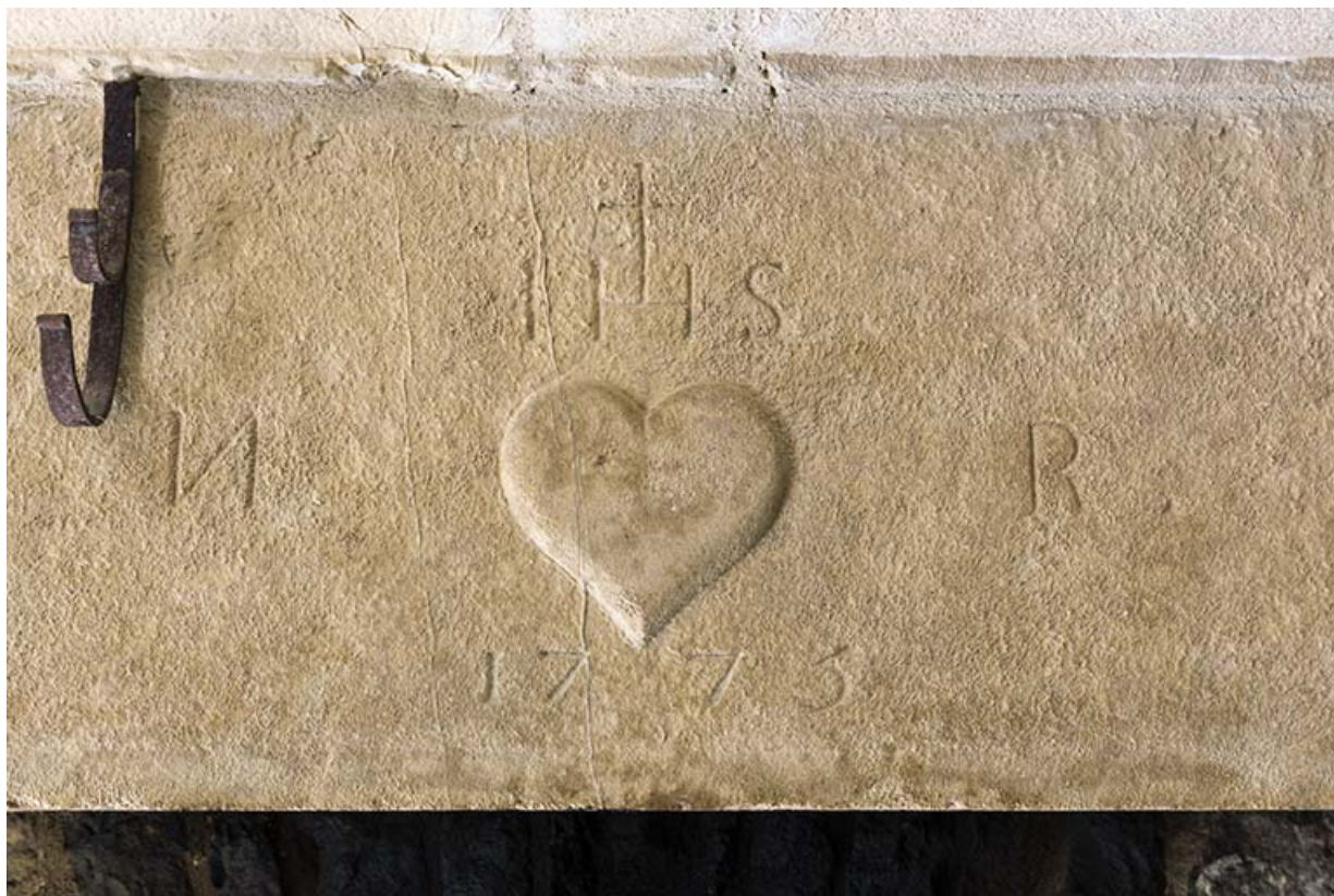
Cheminée : détail du faux manteau. Date portée : 1775. Deux initiales : N R de part et d'autre d'un coeur surmonté d'IHS. 70, Betaucourt place du Petit-Magny
