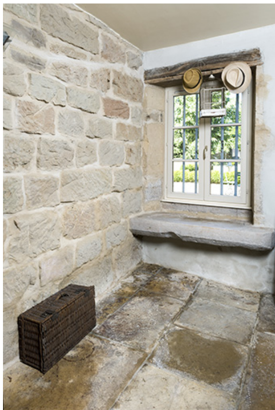
Pierre d'évier sous une baie et détail de mur intérieur au rez-de-chaussée de l'habitation. 70, Betaucourt place du Petit-Magny
