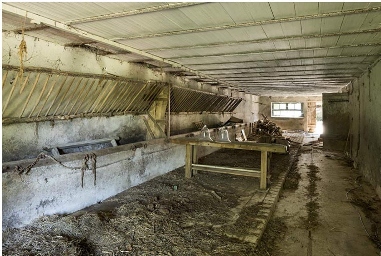
Vue intérieure de l'écurie.
