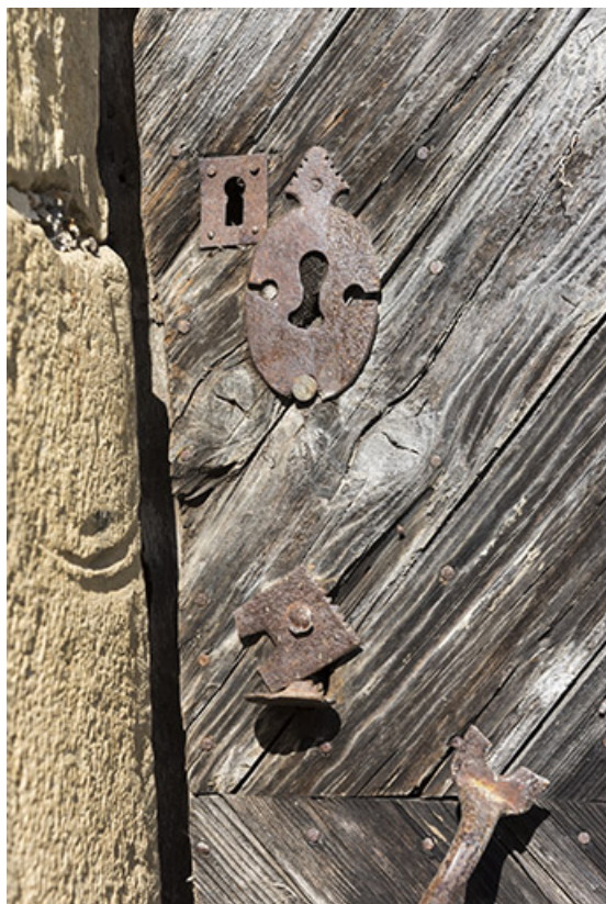
Détail de serrurerie de la porte de gauche.
