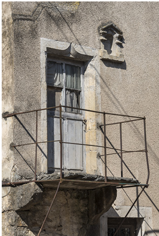
Détail de la porte en accolade.
