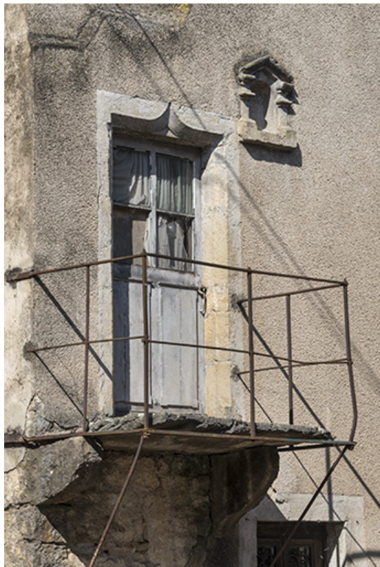
Détail de la porte en accolade.
