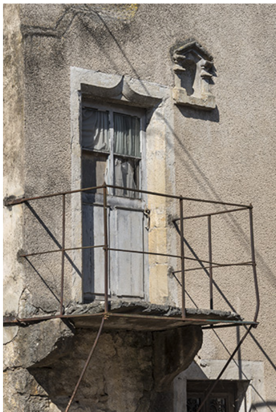
Détail de la porte en accolade.
