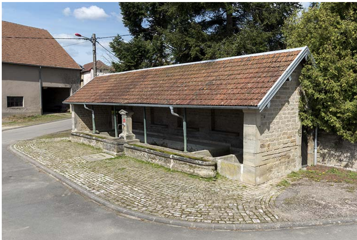
Fontaine-lavoir à l'angle de la Grande rue et de la rue du Bas : vue de trois-quart sud-est. 70, Betaucourt
