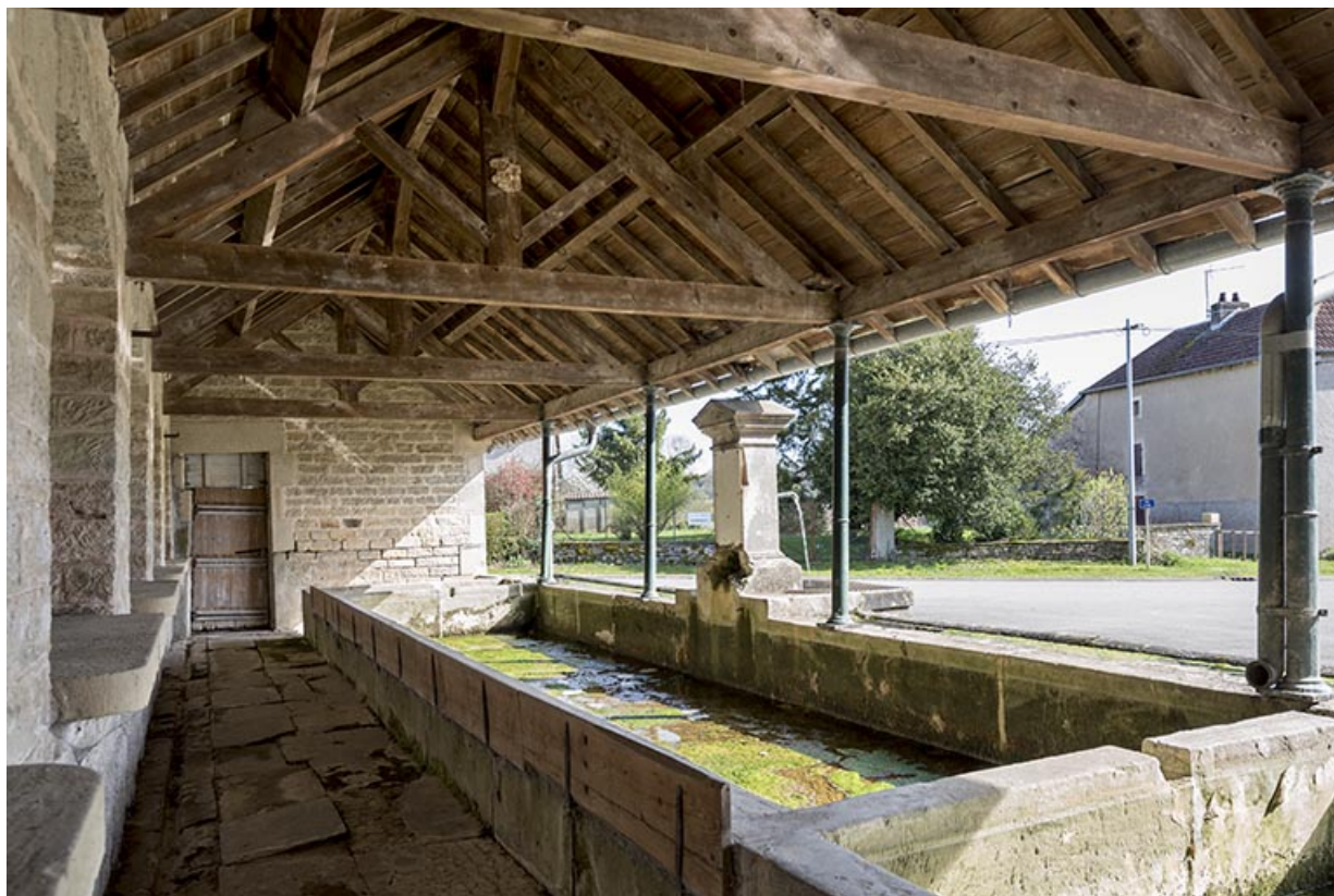
Fontaine-lavoir à l'angle de la Grande rue et de la rue du Bas : vue intérieure depuis le nord-ouest. 70, Betaucourt
