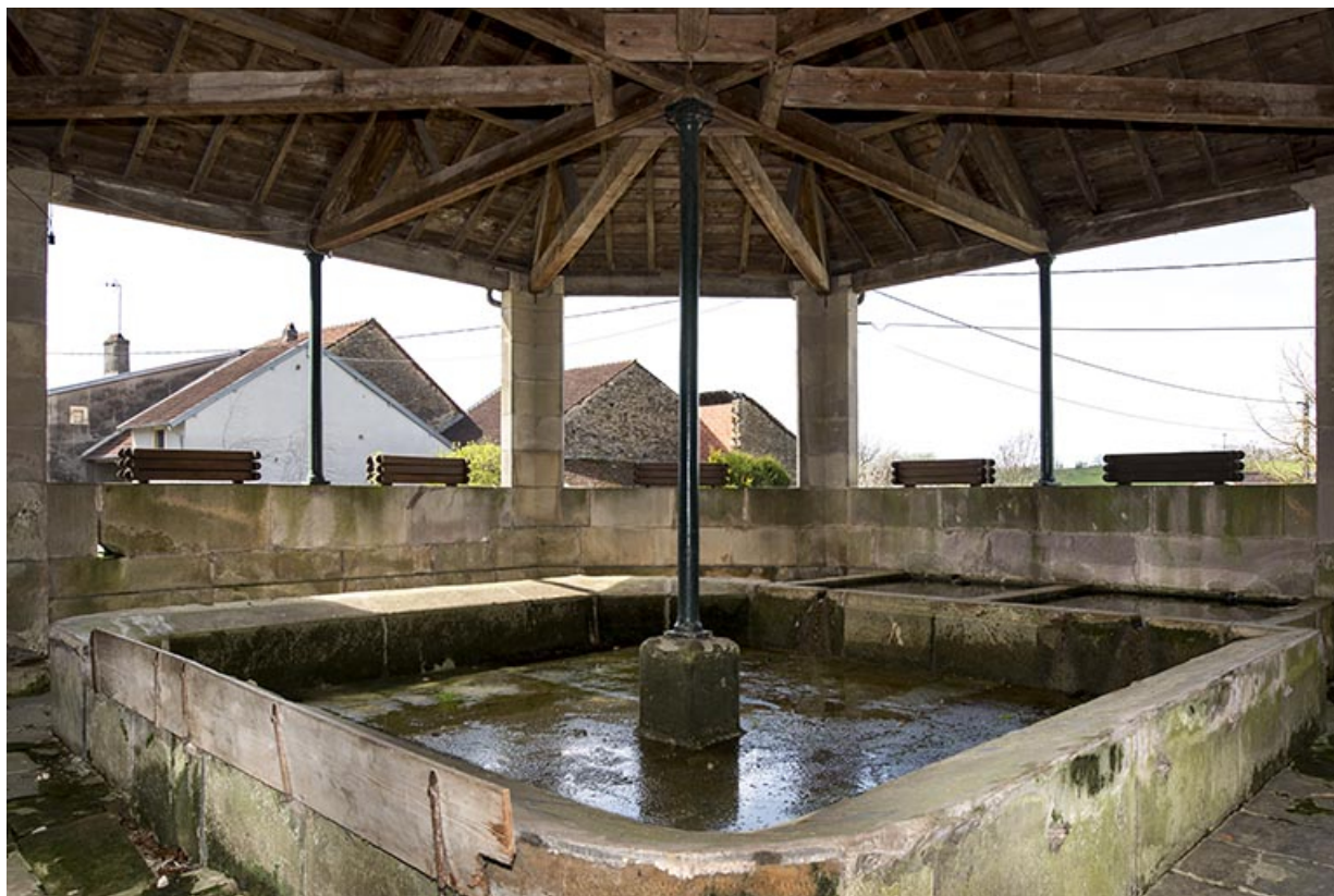
Fontaine-lavoir rue Saint Antoine : vue intérieure depuis l'angle nord-est. 70, Betaucourt
