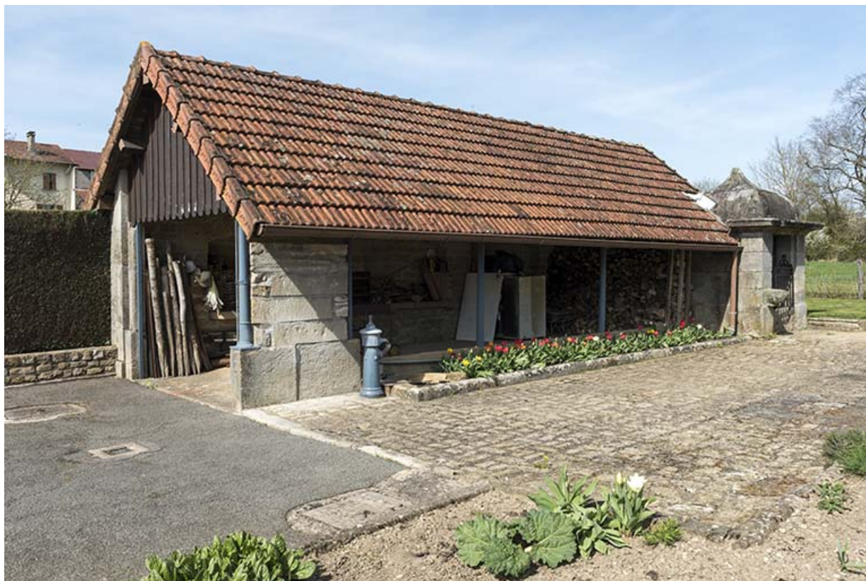
Ancienne fontaine-lavoir, 2 rue de Jonvelle : vue de trois-quart sud. 70, Betaucourt
