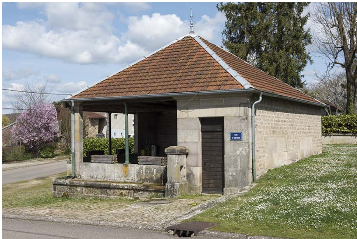
Fontaine-lavoir rue Saint Antoine : vue de trois-quart nord-est. 70, Betaucourt
