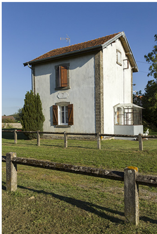
Ancienne emprise des voies et ancienne maison du garde-barrière vue de trois-quart nord-ouest. 70, Corre avenue de la gare
