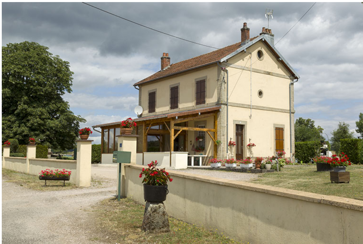
L'ancienne gare transformée en maison d'habitation.
