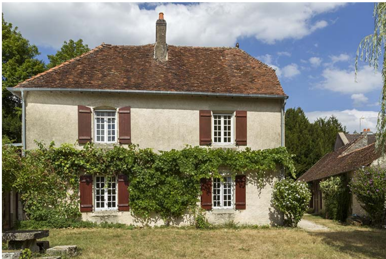
Façade latérale gauche de l'aile en retour d'équerre.
