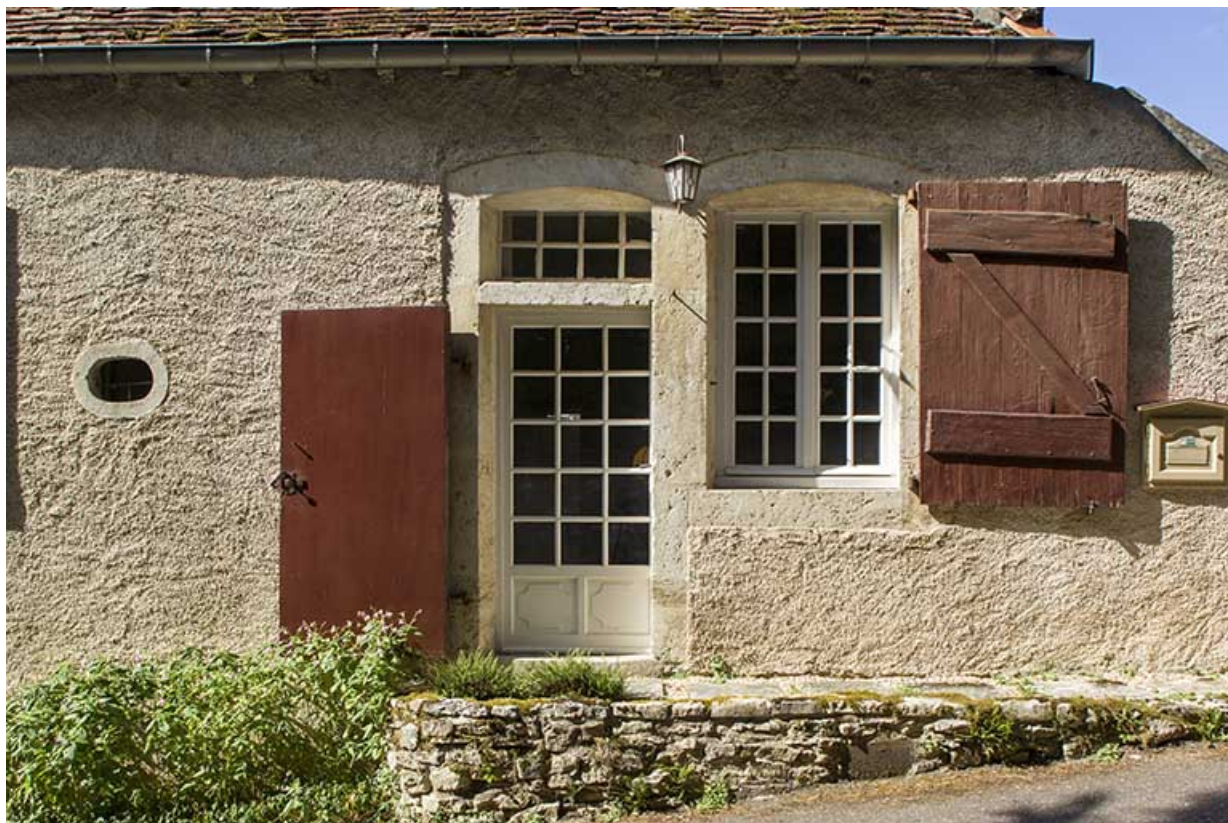
Détail de l'extrémité droite de la façade, rue du Château.
