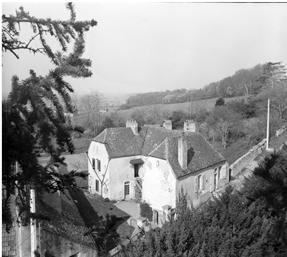
[Vue d'ensemble depuis le parc du château], 1955.
