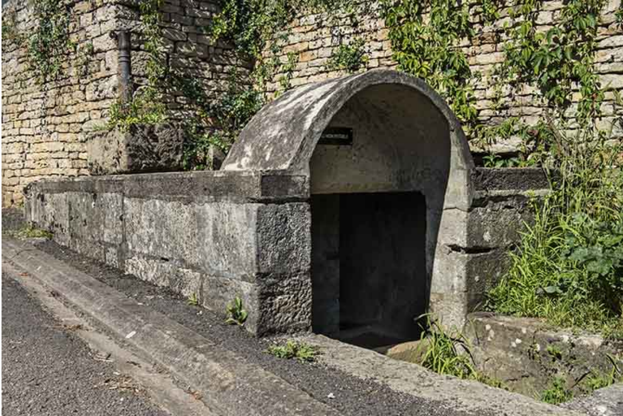
Vue sur l'entrée du puisard avec la couverture en béton armé.
