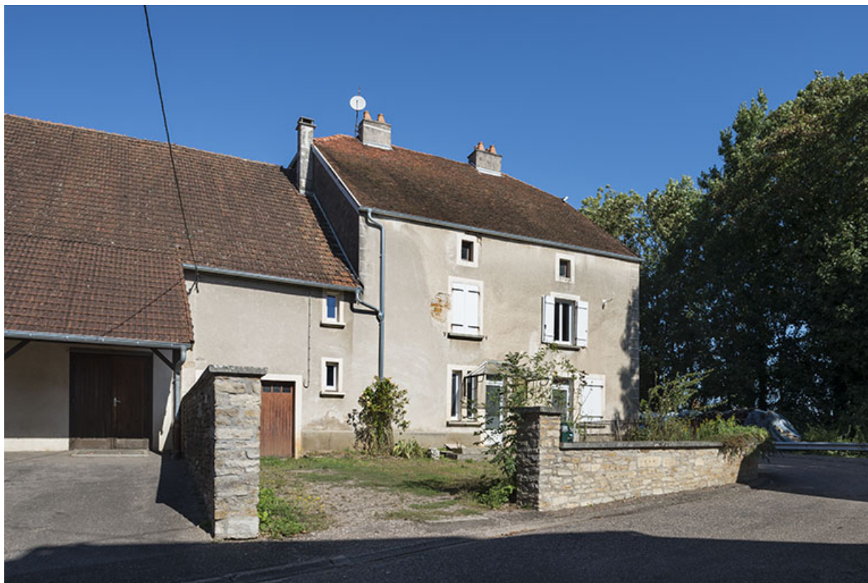
Vue depuis la rue de l'Eglise.
