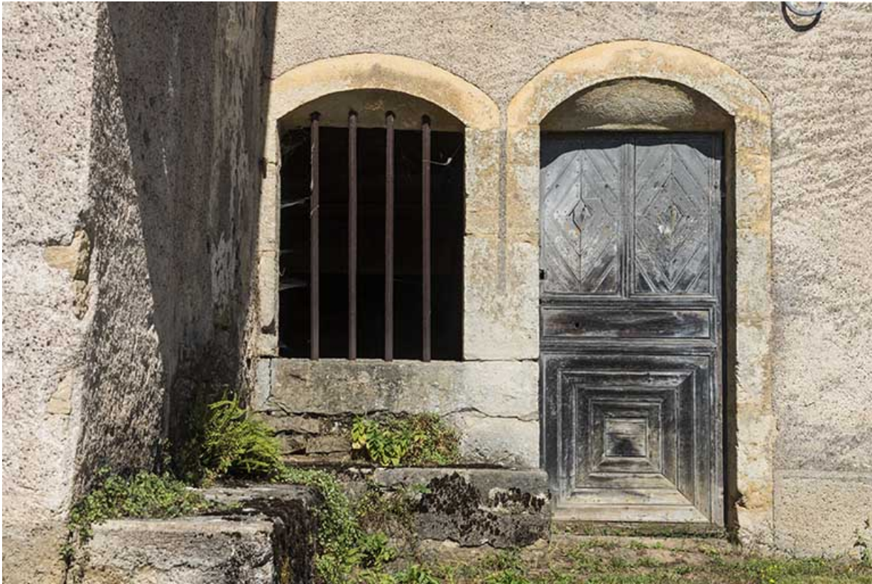
Détail sur les ouvertures avec leurs arcs segmentaires délardés.
