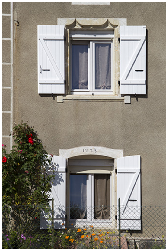
Façade antérieure : baie à double accolade et baie à linteau en arc segmentaire délardé portant la date 1723. 70, Ray-sur-Saône, 5 place Gabrielle de Salverte
