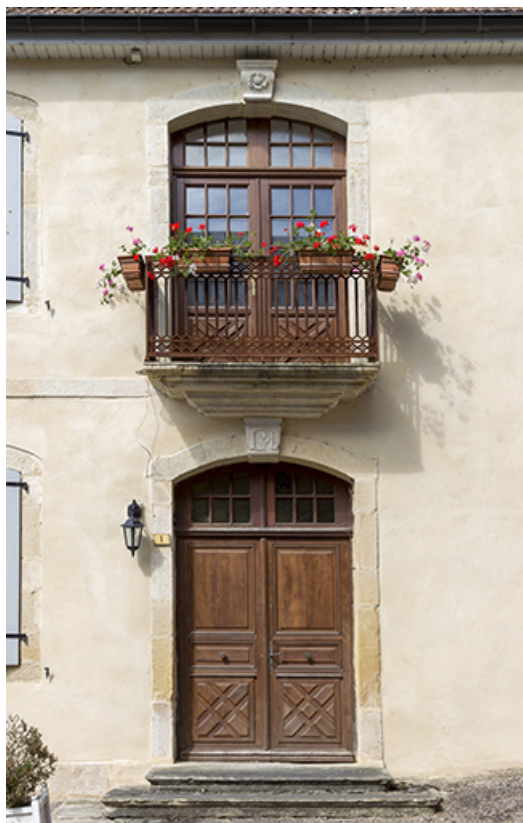
Détail : travée centrale de la façade sur rue. 70, Ray-sur-Saône, 1, 3 rue du Château
