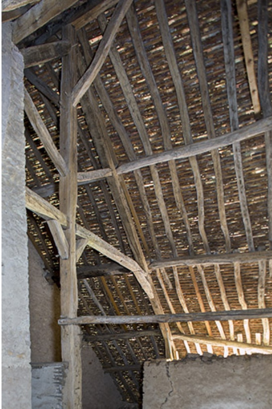
Intérieur : détail de la charpente.
