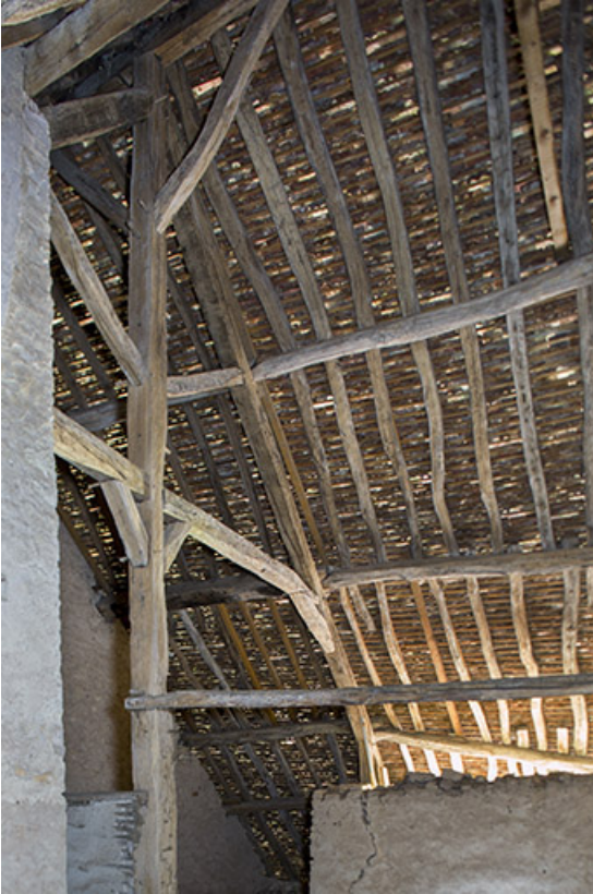
Intérieur : détail de la charpente.
