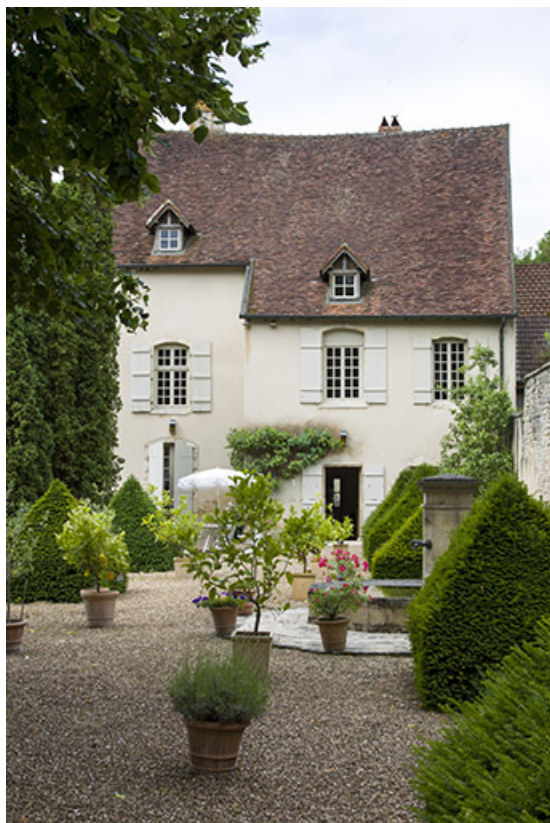
Façade postérieure donnant sur le jardin.
