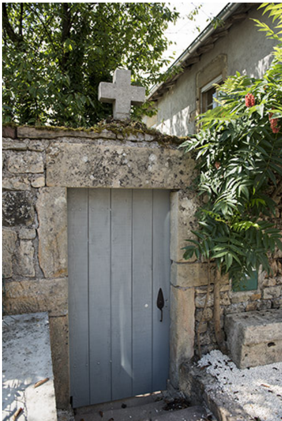
Entrée de l'ancienne maison des soeurs, ancienne maison d'école des filles. 70, Vouécourt
