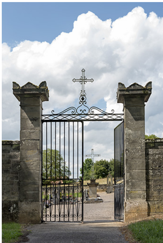
Porte flamande de l'entrée du cimetière.
