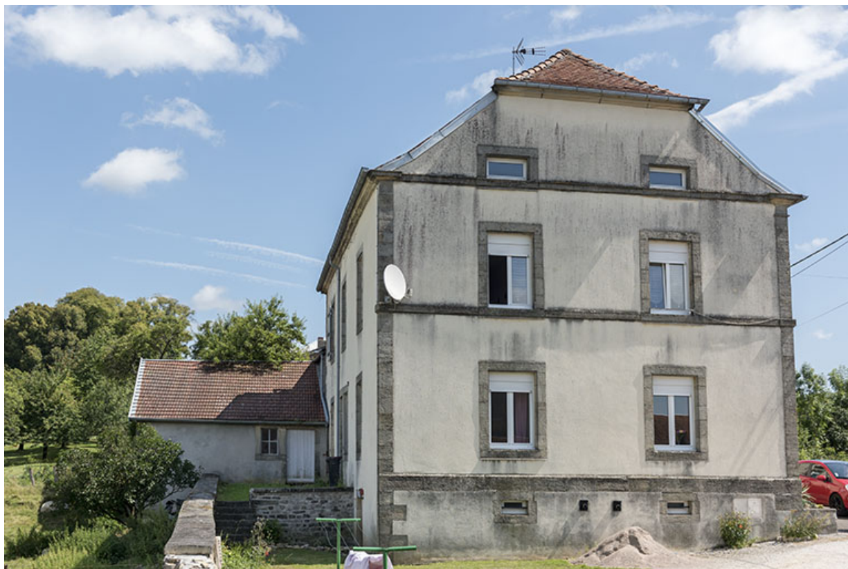
Maison d'école. Vue du pignon ouest et, au second plan, de la chambre de four. 70, Vougécourt
