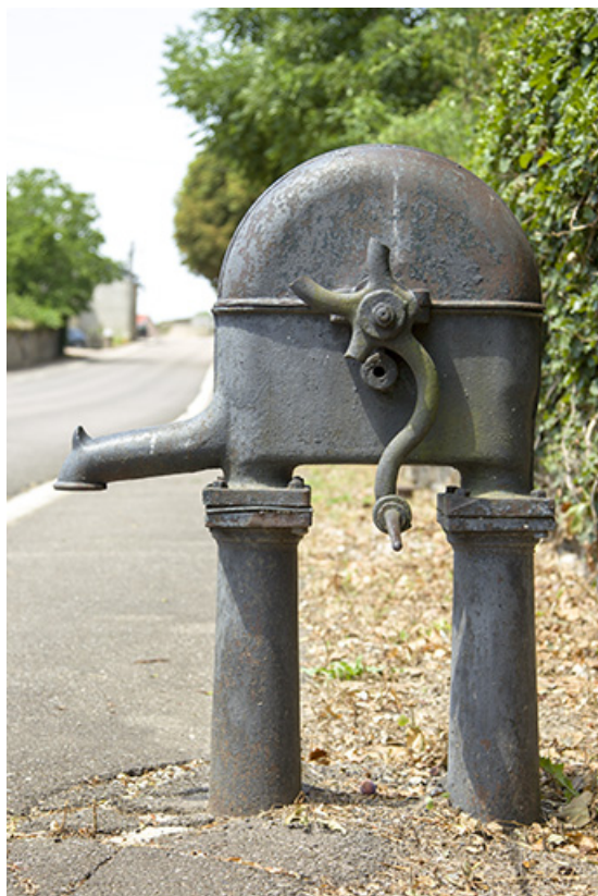
borne fontaine 3 rue des Marronniers : vue du sud-est. 70, Vouécourt
