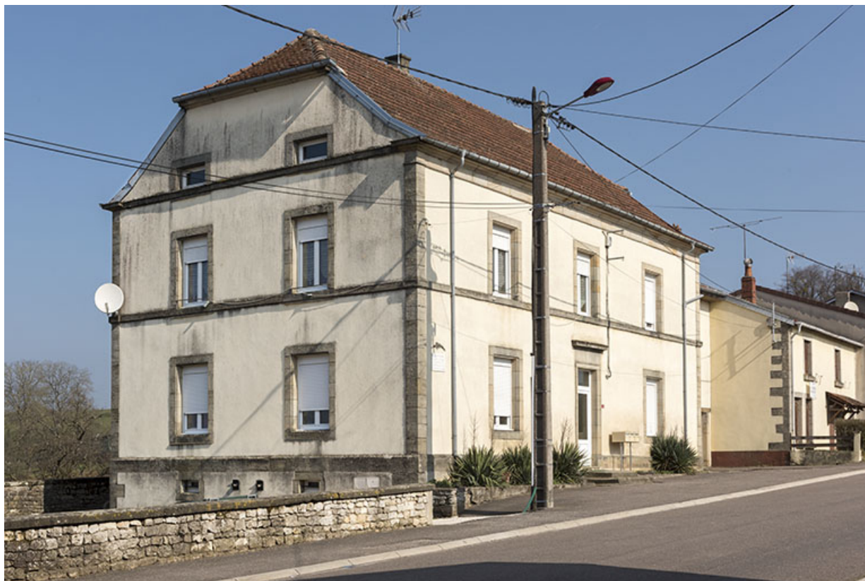
Maison d'école. Vue de trois-quart sud-ouest. 70, Vouécourt
