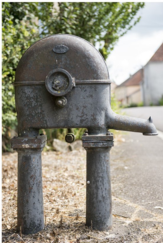
Borne fontaine 3 rue des Marronniers : vue du nord-ouest. 70, Vouécourt
