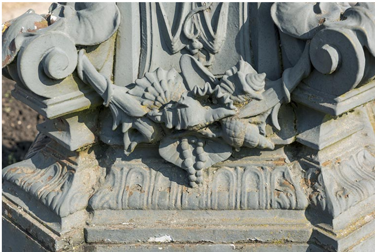
Fontaine du centre : détail du socle. 70, Vougécourt
