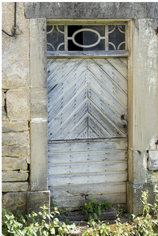
Détail de menuiserie et imposte de la porte piétonnière d'une ferme chemin de Seroux. 70, Vougécourt
