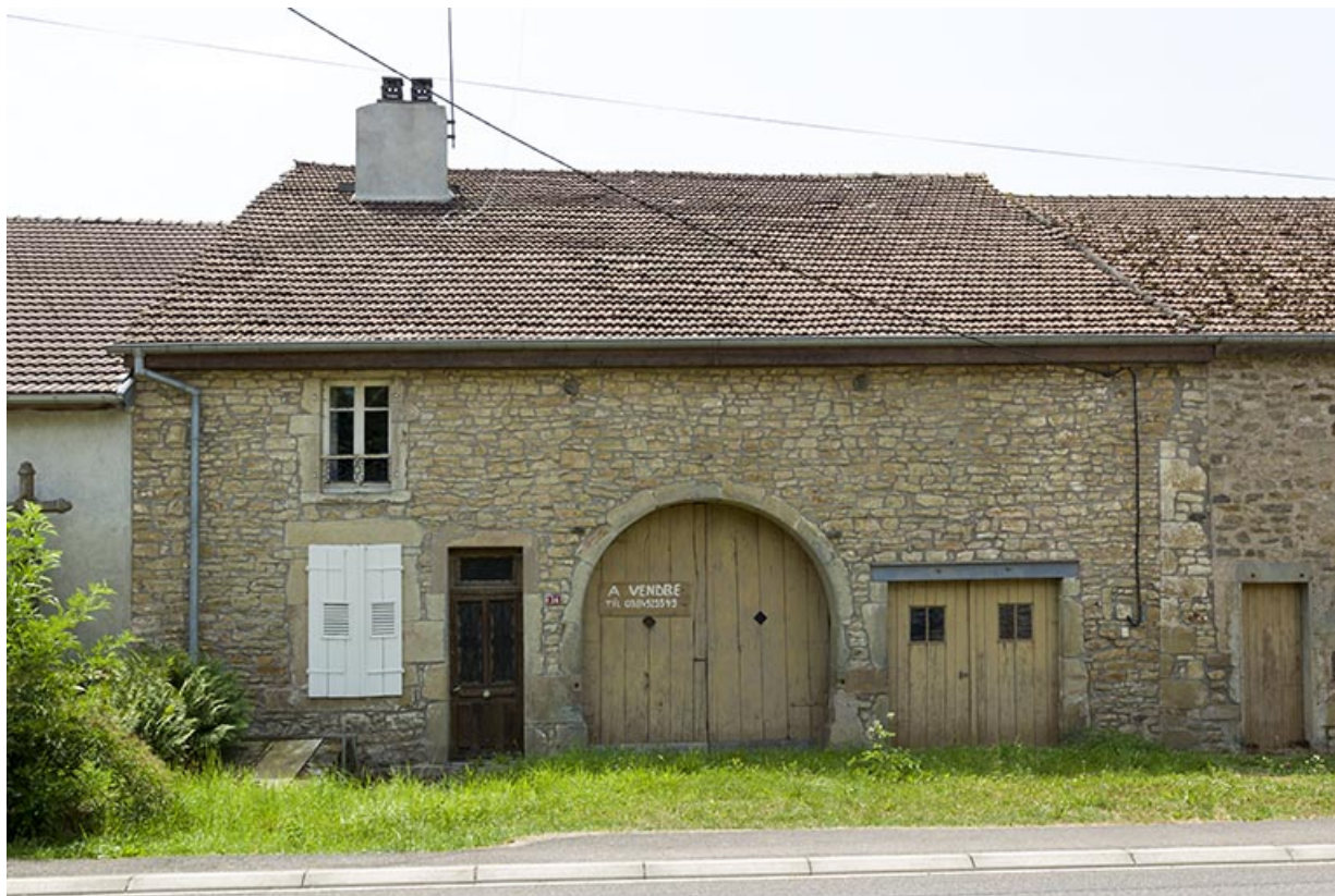
Maison ferme avec trappon de cave sur rue : 14, rue des Marronniers. 70, Vougécourt
