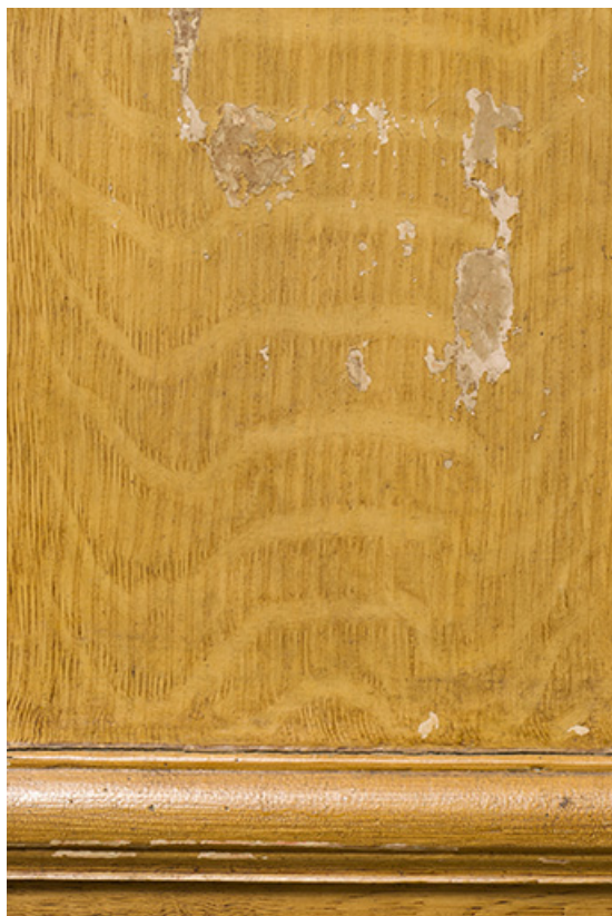
Intérieur : détail des lambris de revêtement du salon. Le papier peint du 18e siècle apparaît sous la toile peinte à l'imitation du bois. 70, Ray-sur-Saône, 8, 10 Grande Rue
