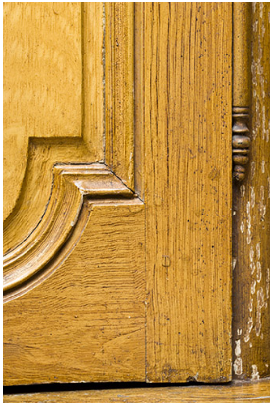
Intérieur : détail des lambris de revêtement du salon, toile peinte à l'imitation du bois. 70, Ray-sur-Saône, 8, 10 Grande Rue
