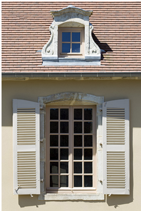
Façade antérieure : une fenêtre du premier étage et une lucarne de l'étage de comble. 70, Ray-sur-Saône, 8, 10 Grande Rue
