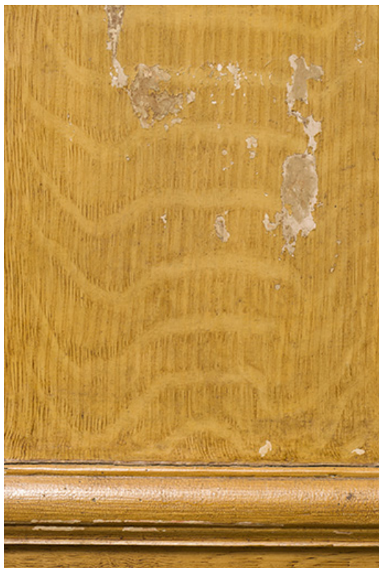
Intérieur : détail des lambris de revêtement du salon. Le papier peint du 18e siècle apparaît sous la toile peinte à l'imitation du bois. 70, Ray-sur-Saône, 8, 10 Grande Rue
