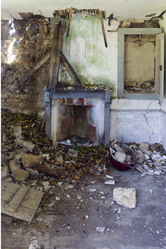
Intérieur du bâtiment : une pièce avec cheminée.
