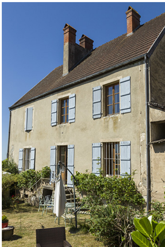
Façade postérieure du logis, côté jardin.
