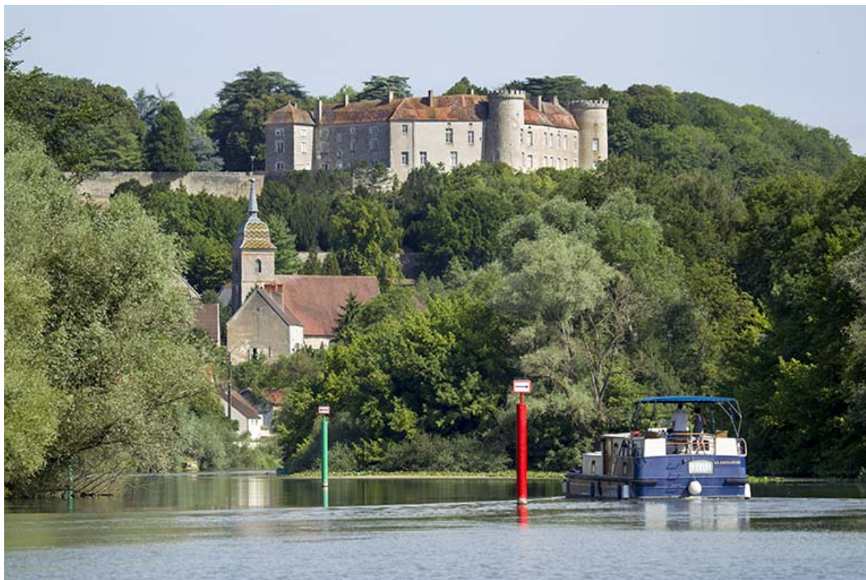
Vue du château surplombant l'église paroissiale Saint-Pancrace et la Saône. 70, Ray-sur-Saône
