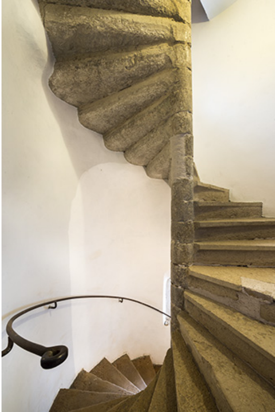
L'escalier à vis dans la tour.
