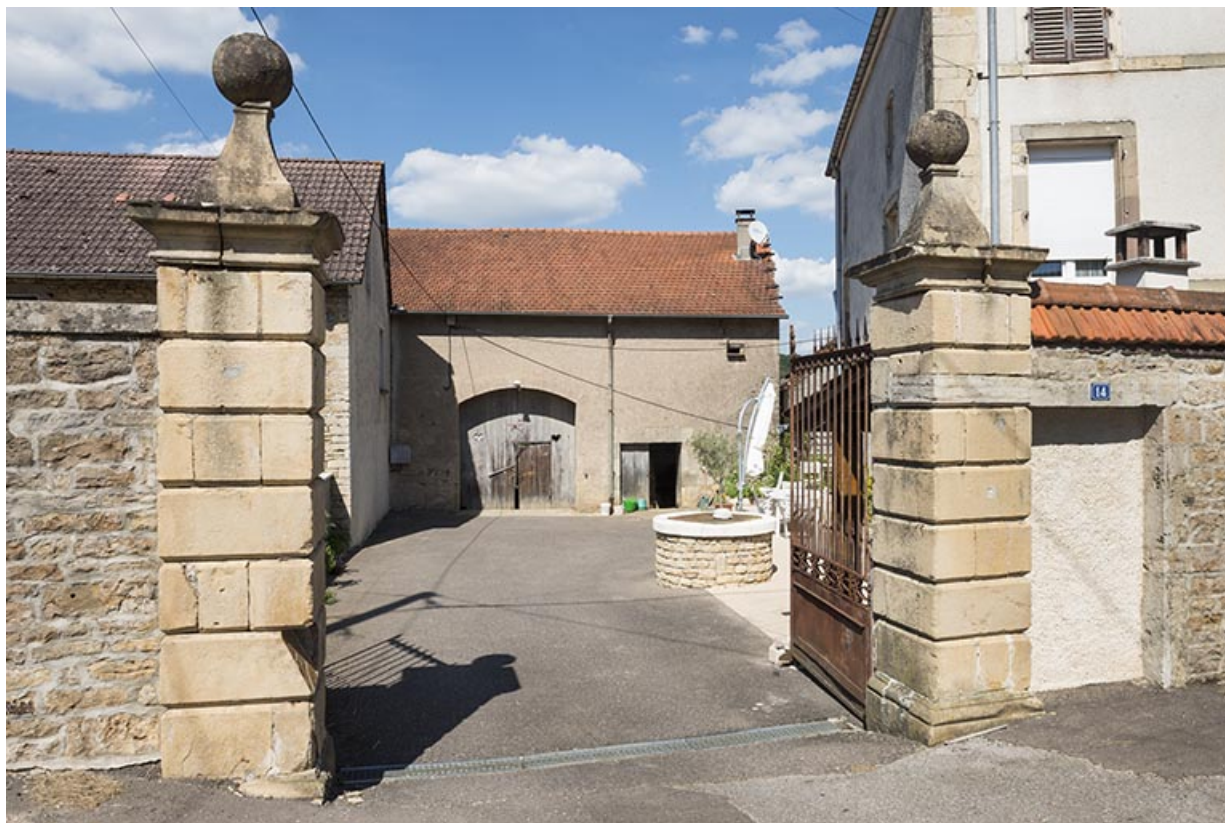
Le portail avec ses piliers.
