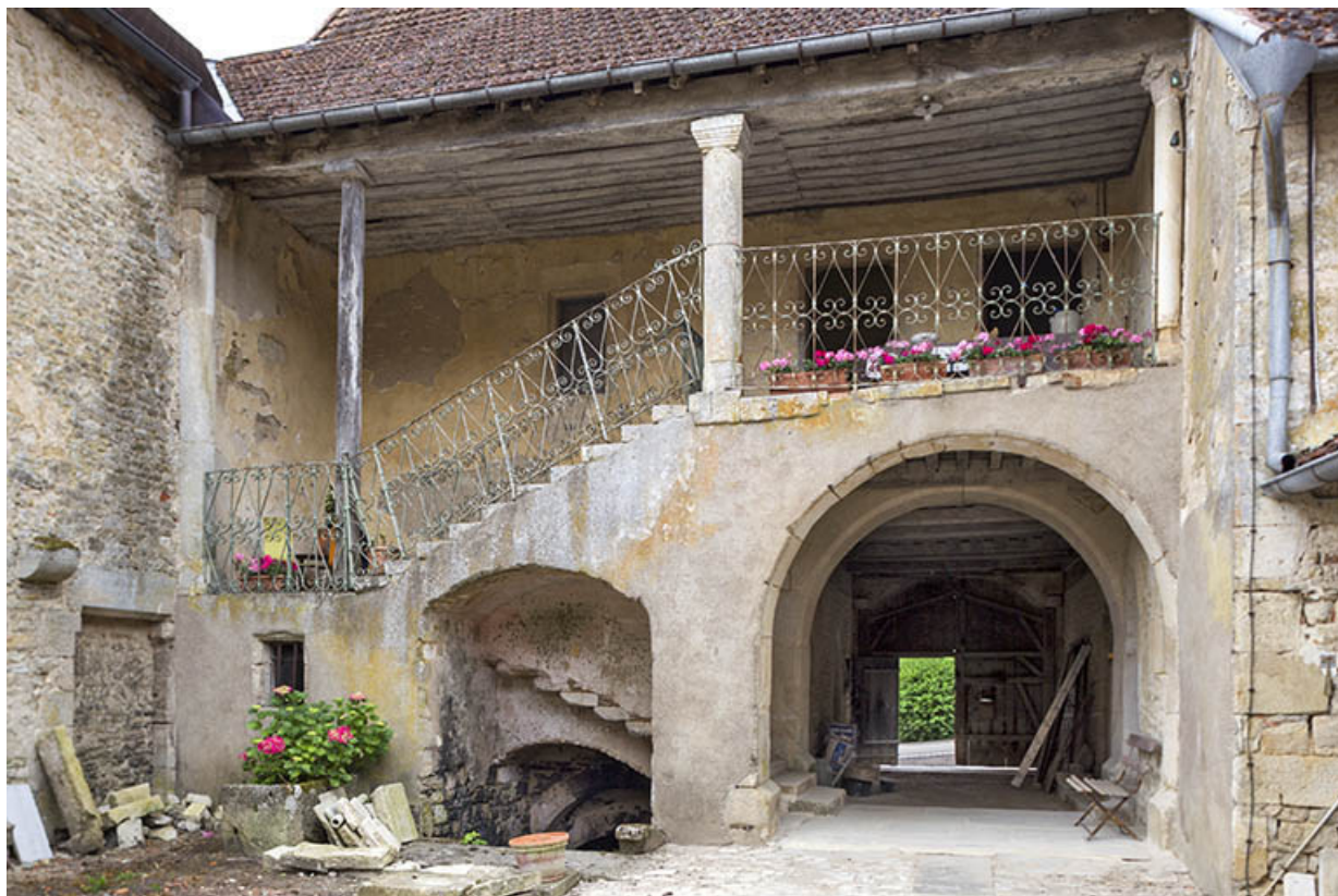
Demeure dite le Chapitre au 6 rue du Château, façade sur cour. 70, Ray-sur-Saône, 6 rue du Château
