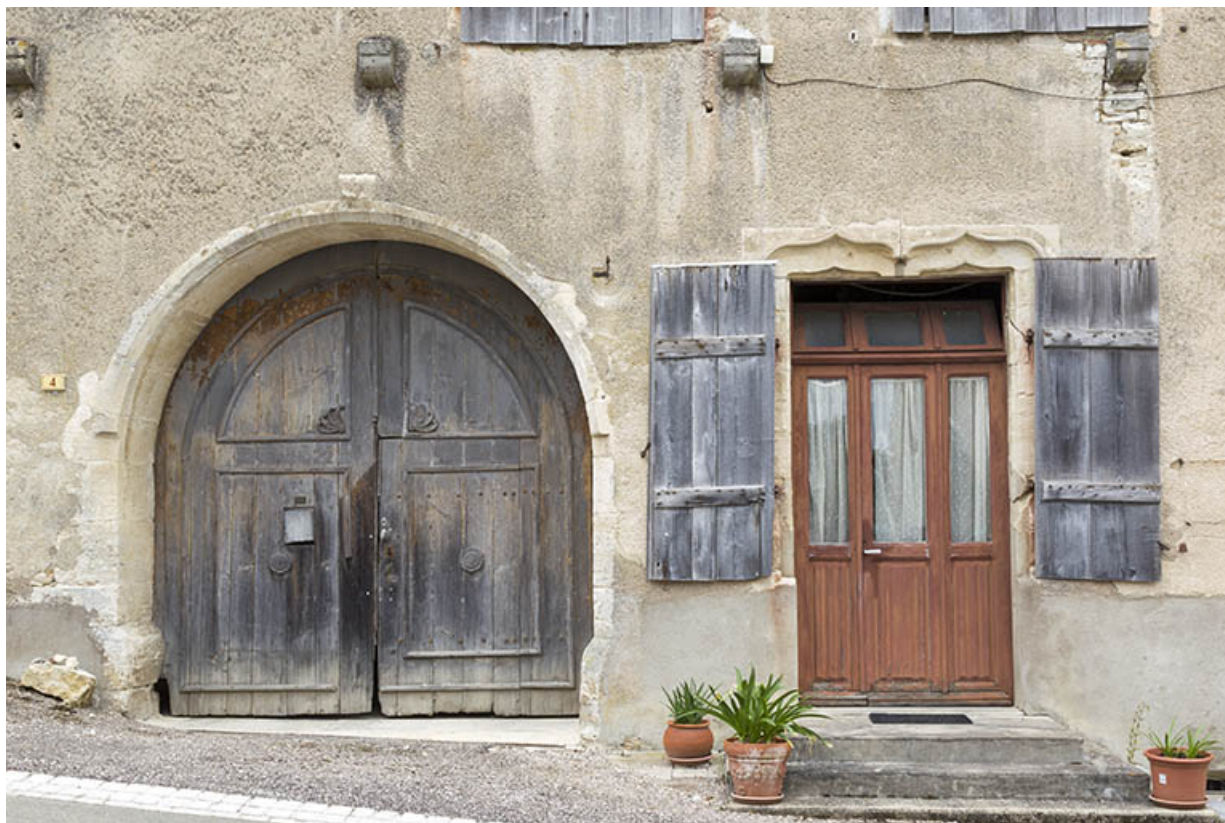
Façade antérieure : porte cochère et baie modifiée avec linteau en accolade. 70, Ray-sur-Saône, 6 rue du Château
