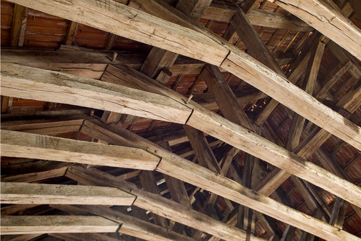
Détail de l'assemblage de la charpente.
