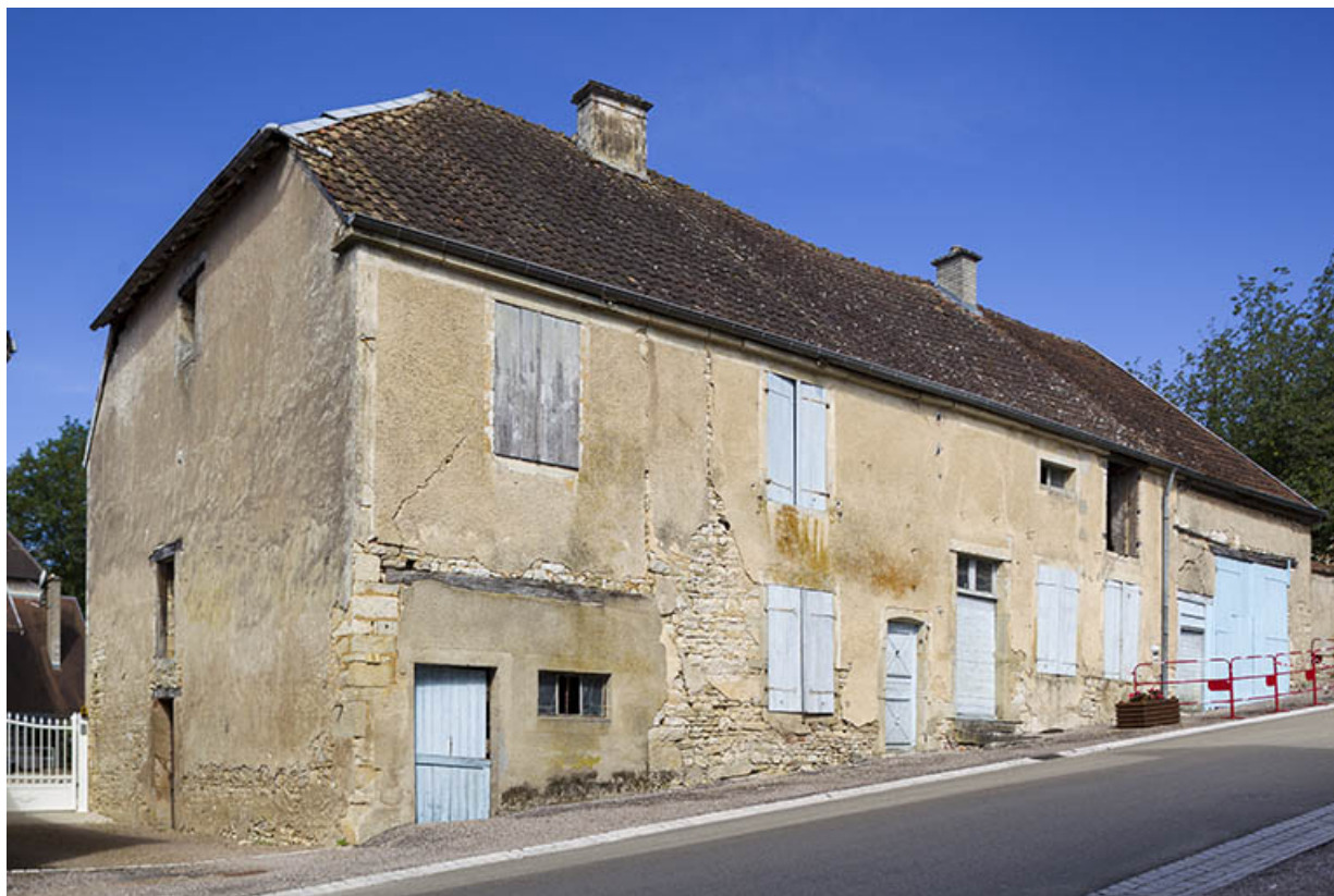
Ferme 5 rue du Château : vue de trois quart gauche. 70, Ray-sur-Saône
