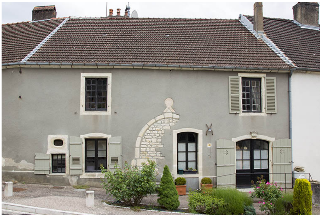
Maison 4 place Gabrielle de Salvete, vue rapprochée de la façade antérieure. 70, Ray-sur-Saône
