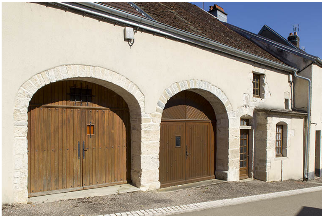
Ferme (modifiée) 11 Grande Rue : exemple d'avancée appelée "souillarde" contenant l'évier. 70, Ray-sur-Saône
