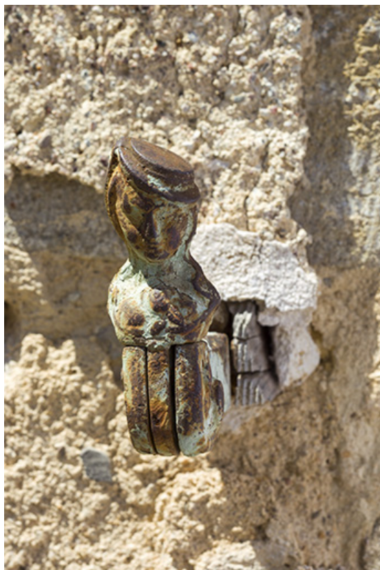
Ferme 5 rue du Château : détail d'un arrêt de volet. 70, Ray-sur-Saône
