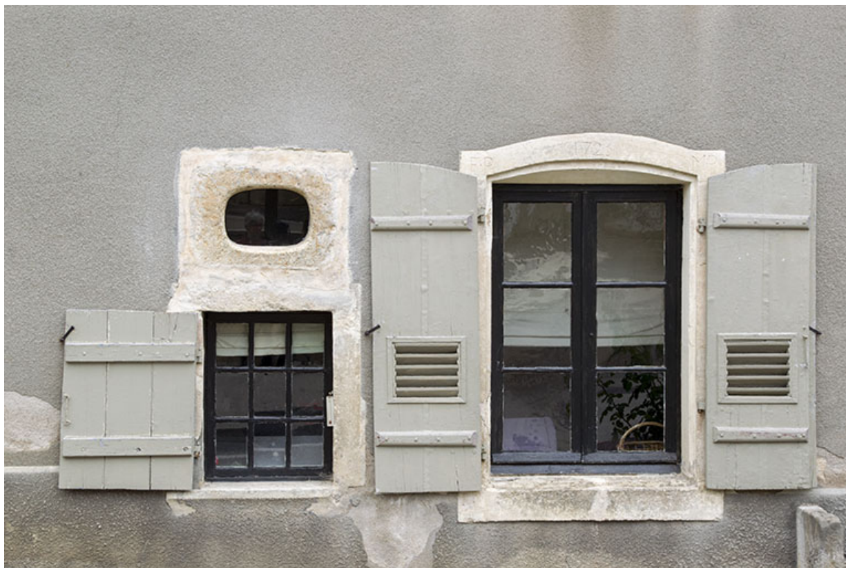
Maison 4 place Gabrielle de Salverte, détail : baies du rez-de-chaussée. 70, Ray-sur-Saône
