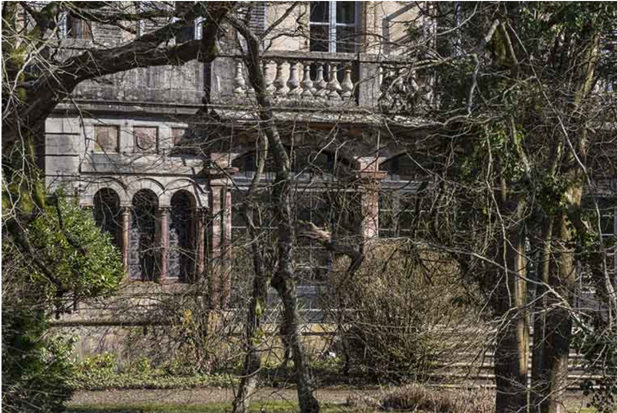
Vue du rez-de-chaussée, façade sud-ouest. 70, Conflandey
