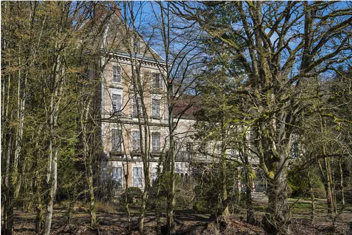
Le pavillon occidental, façade sud-ouest. 70, Conflandey
