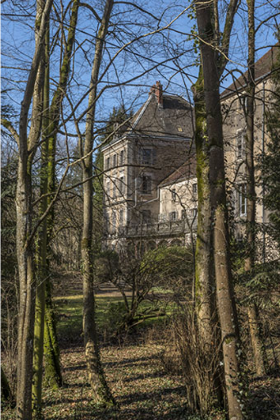
La façade sud-ouest, vue depuis le parc. 70, Conflandey
