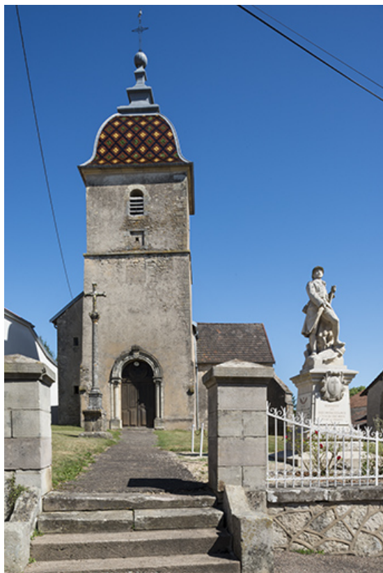
La façade antérieure et le monument aux morts.
