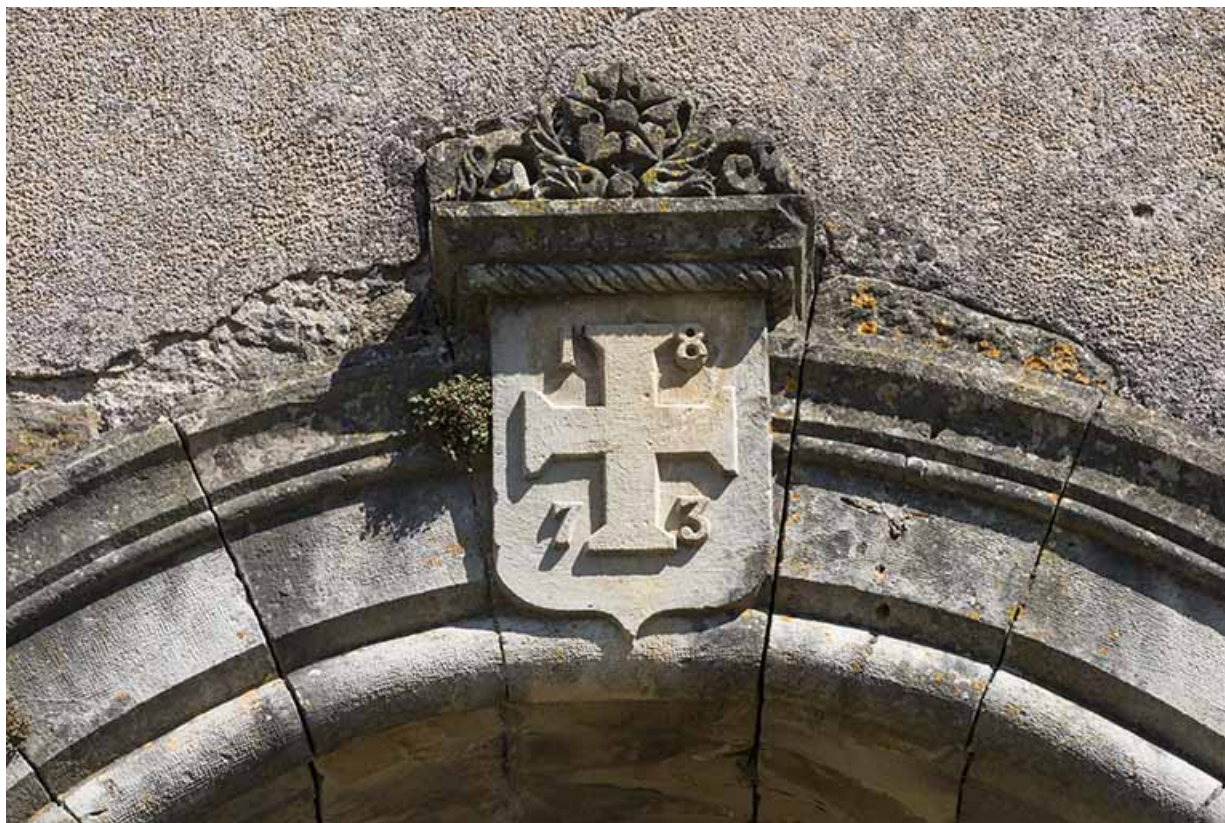
La clé de voûte du portail.
