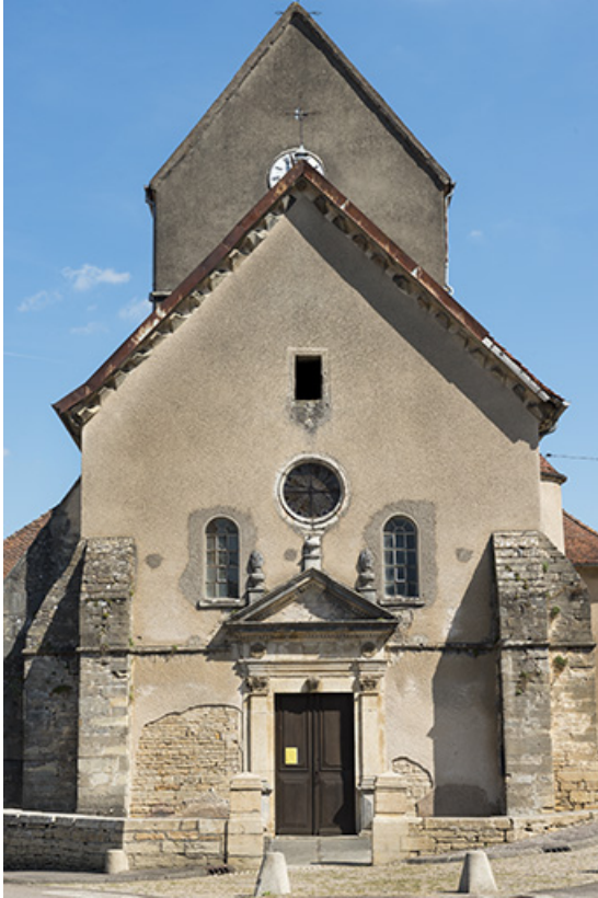
Vue avant restauration (2016).
