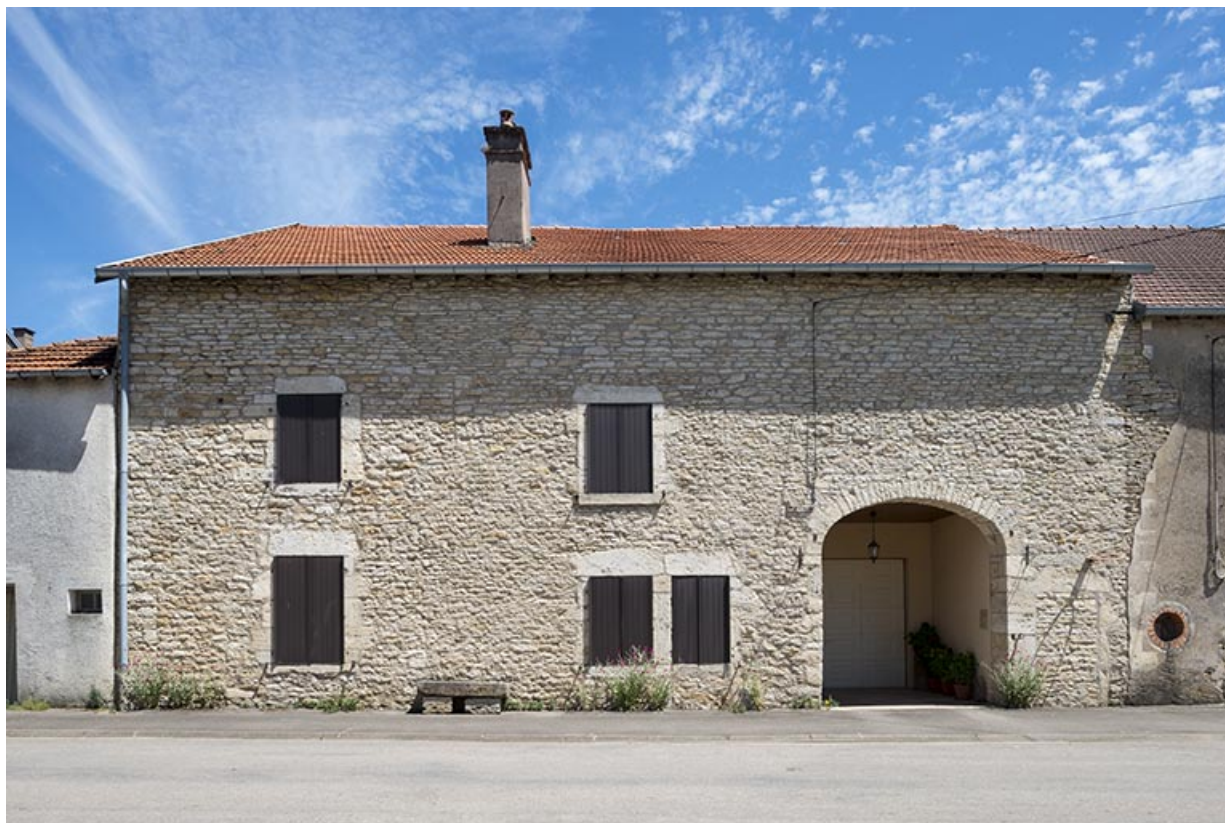
Ferme située au n°16 rue de la Prairie. 70, Ferrières-lès-Scey
