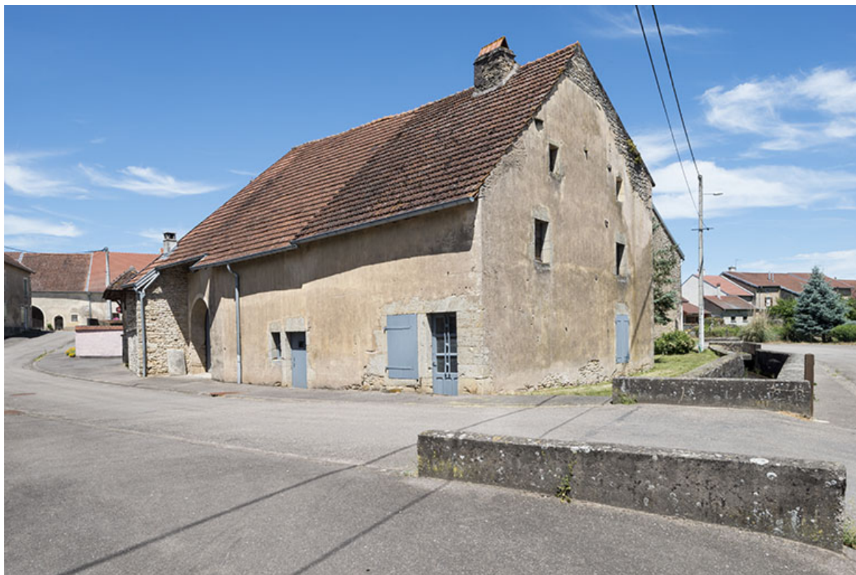
Ferme située à l'extrémité de la rue du Tilleul. 70, Ferrières-lès-Scey
