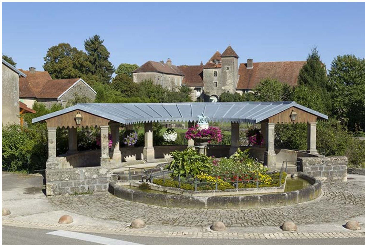
La fontaine sur la place principale du village, et la maison forte en arrière plan. 70, Ferrières-lès-Scey
