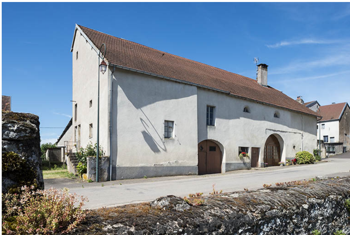
Ferme située au n°2 route de Scey-sur-Saône. 70, Ferrières-lès-Scey
