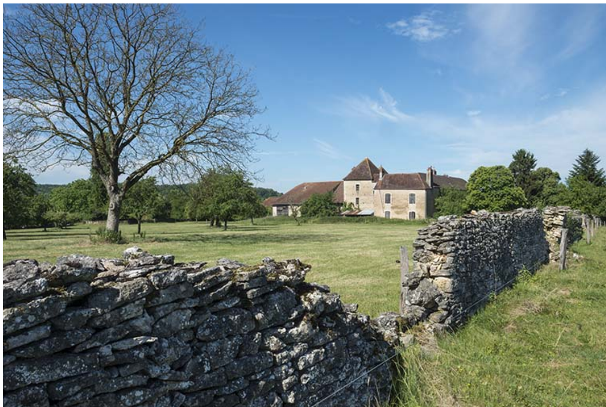
La façade orientale de la maison forte.
