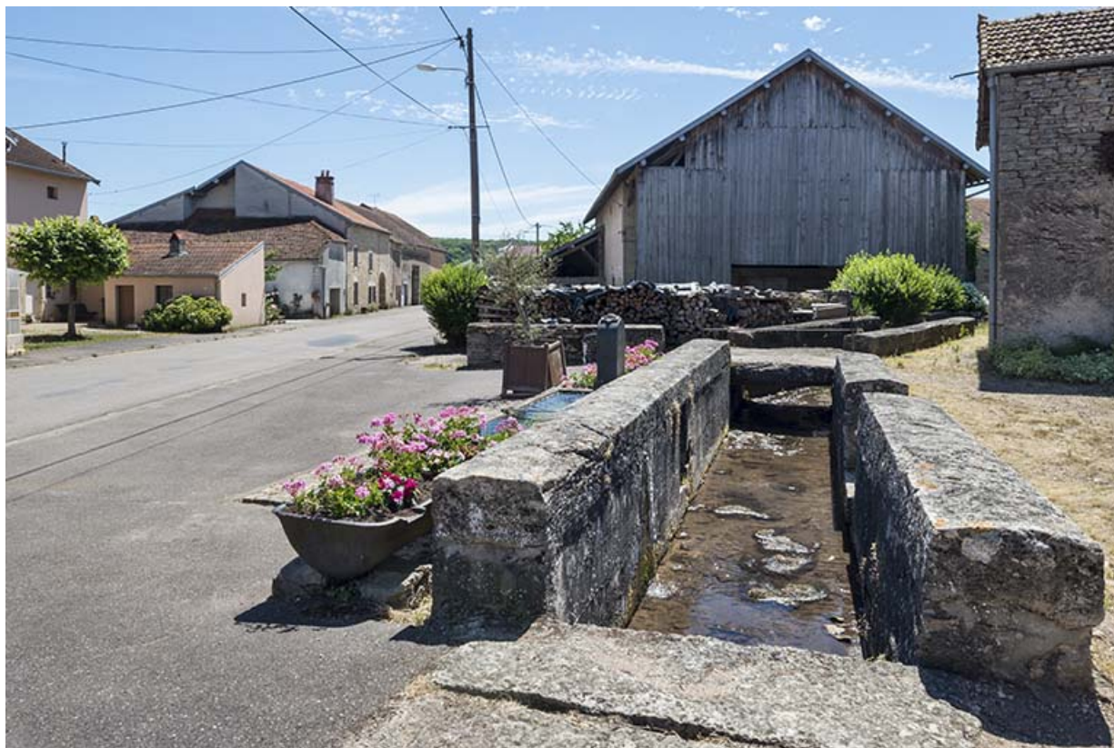
Le ruisseau canalisé traversant le village.
