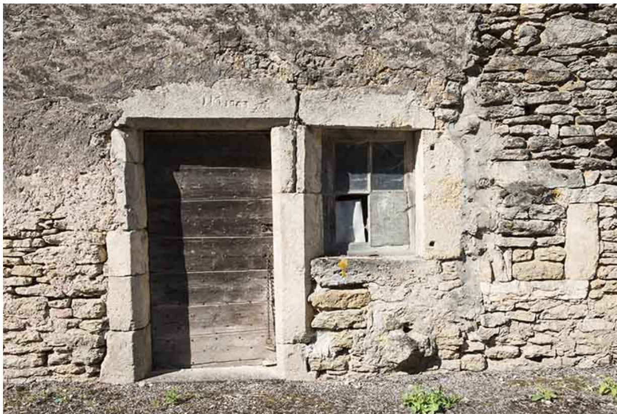
Porte d'entrée de la ferme située à l'angle de l'impasse du Château. 70, Ferrières-lès-Scey
