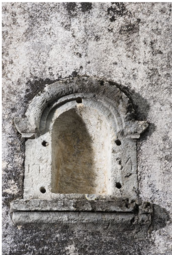
date portée, rue de la Prairie.
