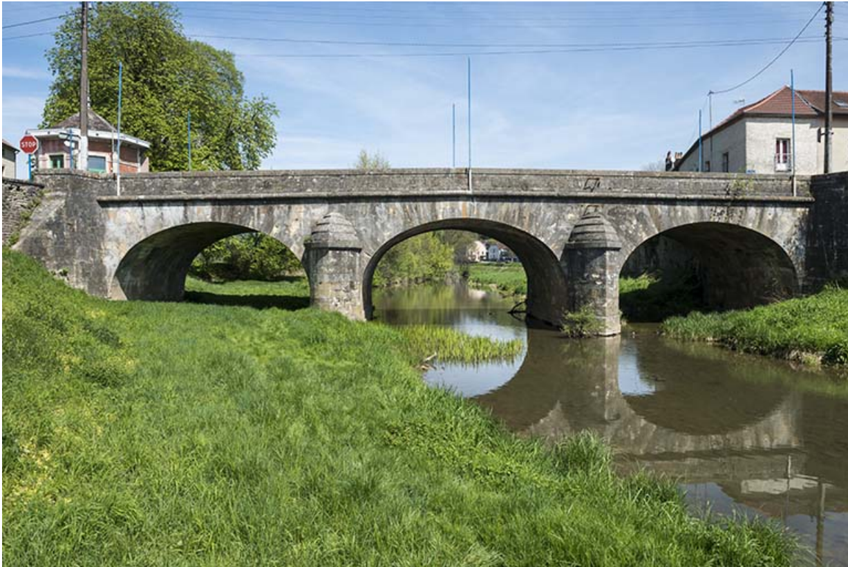
Le pont entre l'île du château et le quartier du Rezelle. 70, Port-sur-Saône
