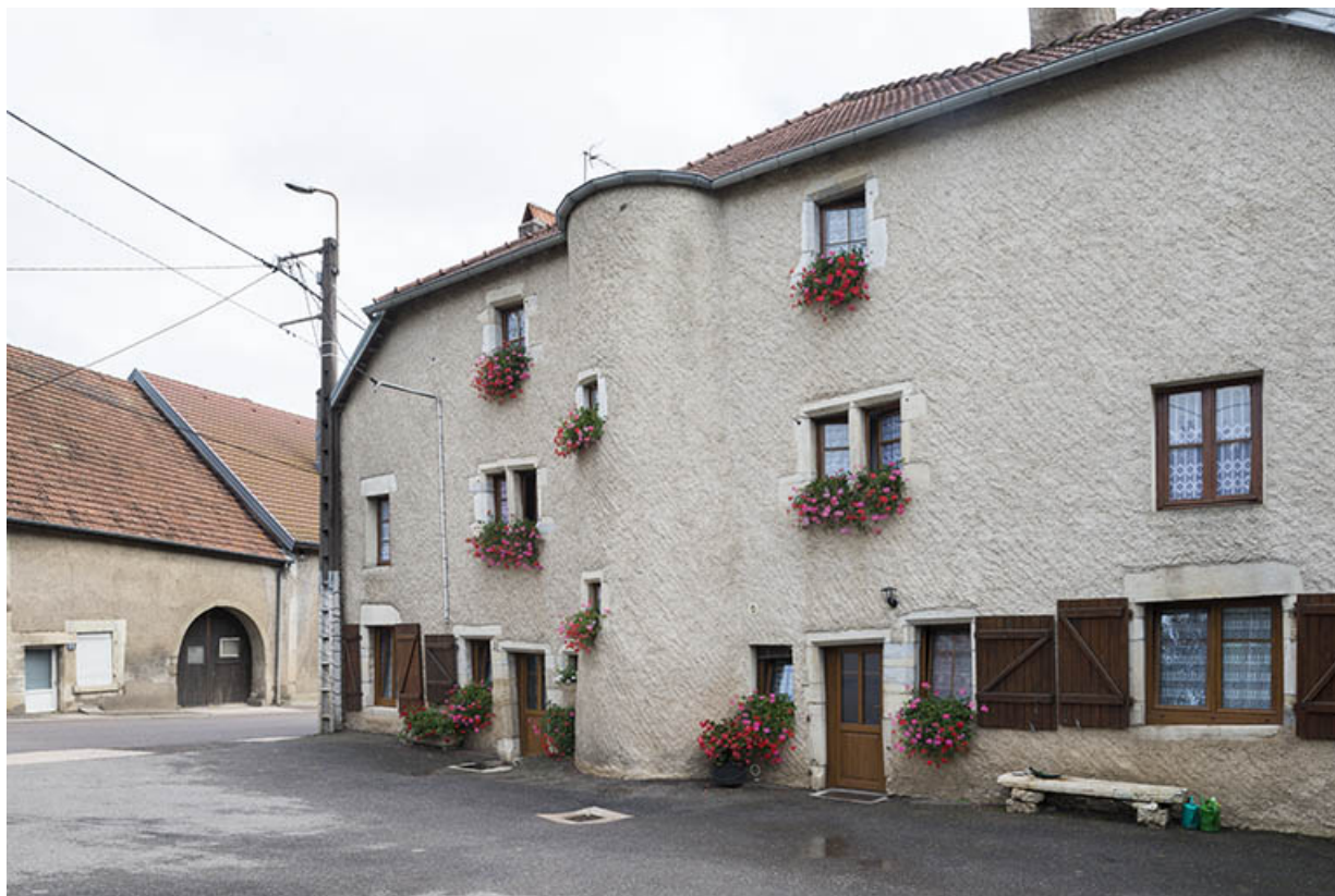
Maison à tour, rue Saint-Valère. 70, Port-sur-Saône
