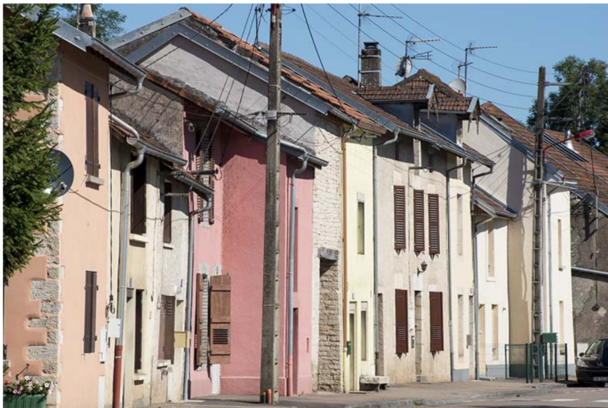
Alignement de maisons, rue du Magny. 70, Port-sur-Saône
