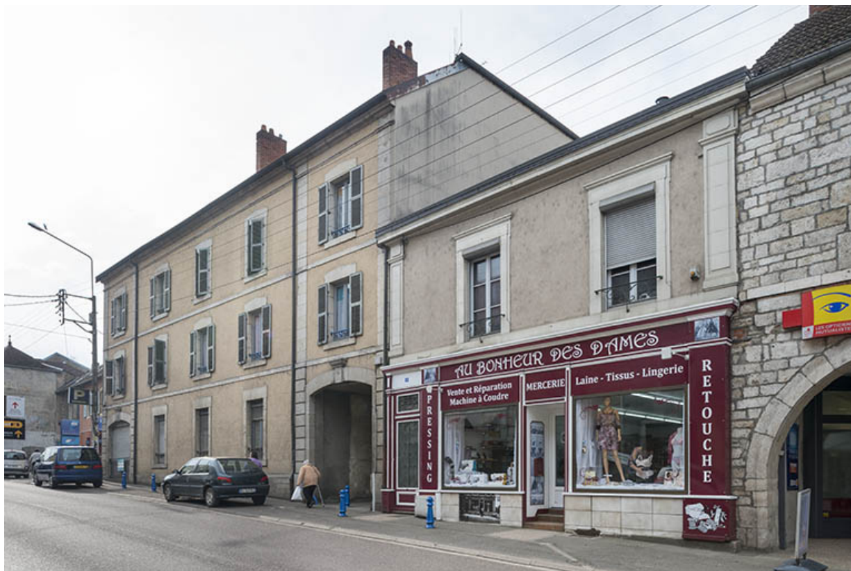
Commerces et anciens entrepôts "Madiot". 70, Port-sur-Saône rue François Mitterrand
