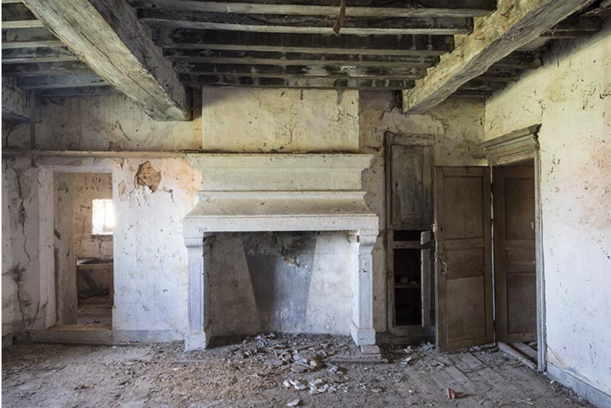
Cheminée de la chambre, logis 16e siècle. 70, Ferrières-lès-Scey
