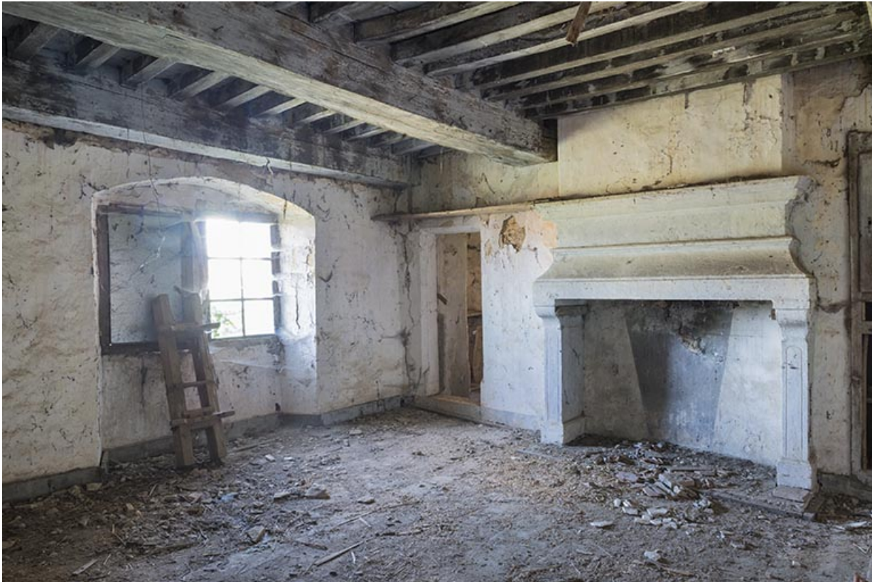
Chambre au premier étage, logis 16e siècle. 70, Ferrières-lès-Scey
