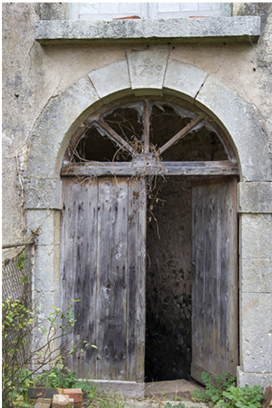
Porte donnant accès à la cave sous le bâtiment du XVIIIe siècle. 70, Ferrières-lès-Scey
