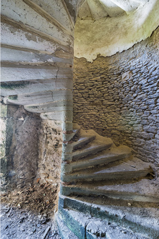
Escalier à vis, rez-de-chaussée du logis 16e siècle. 70, Ferrières-lès-Scey
