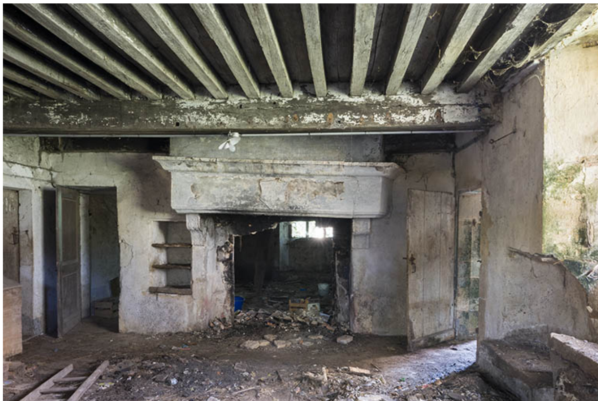
La cheminée, logis 16e siècle. 70, Ferrières-lès-Scey
