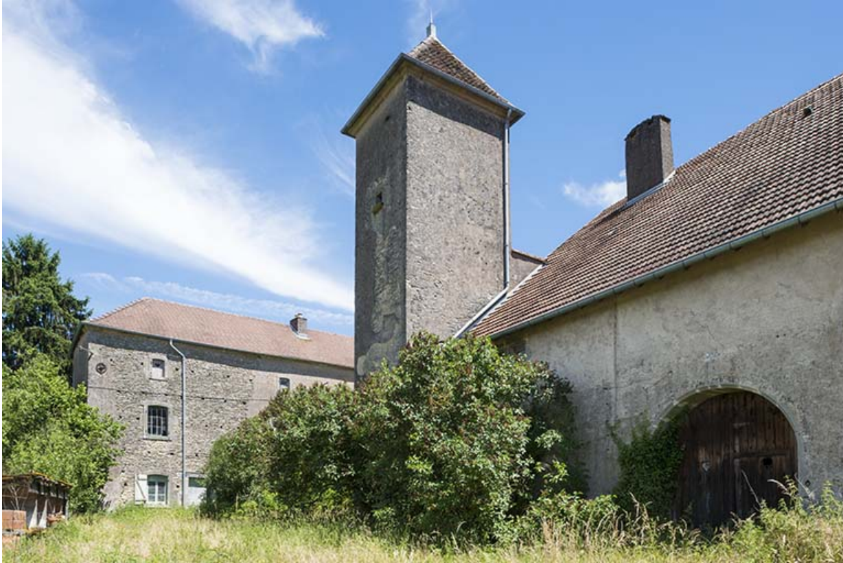
Vue générale sud-ouest du corps de bâtiment. 70, Ferrières-lès-Scey
