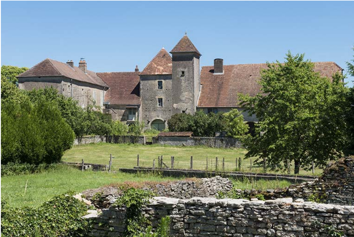
Vue générale de la maison forte.
