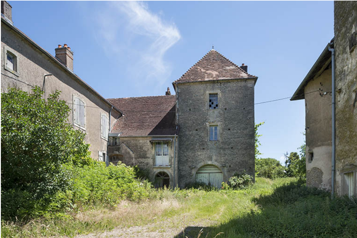
La cour intérieure de la maison forte.
