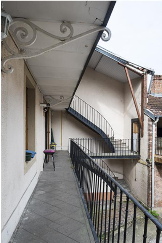
Escalier à cage ouverte, façade postérieure. 70, Port-sur-Saône, 40 rue François Mitterand
