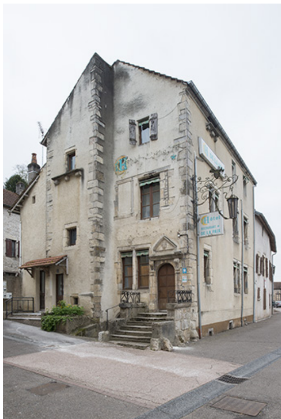
Vue générale depuis la rue Jean Bogé.
