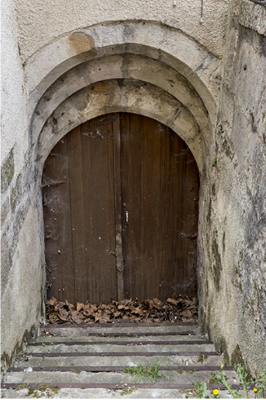
L'accès à la cave par une porte disposant d'une succession d'arcs chanfreinés. 70, Port-sur-Saône rue Jean Bogé
