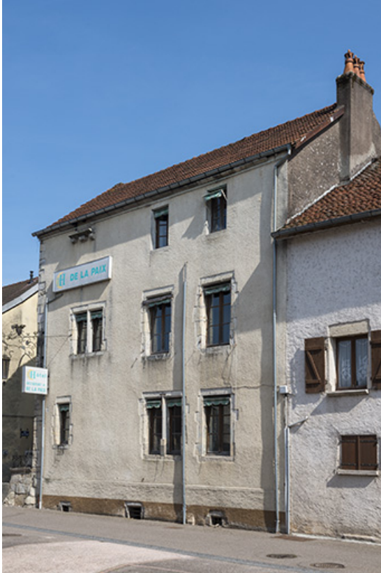
Façade rue Jean Bogé.
