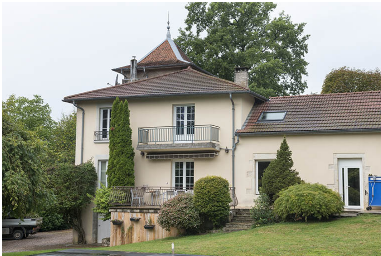
Partie sud de la façade côté parc. 70, Port-sur-Saône avenue du Parc
